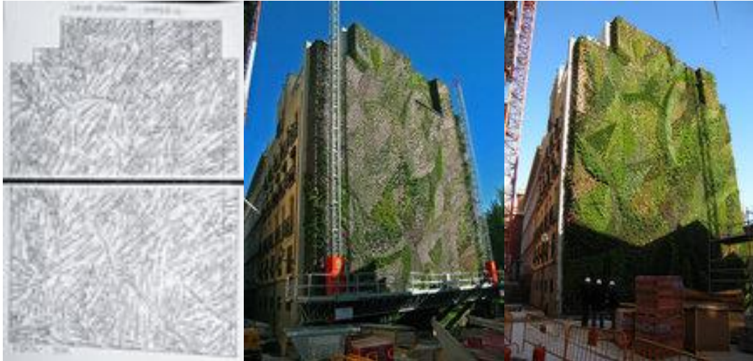
Obrázek 9: Průběh osázení zelené stěny Patricka Blanca (URL 9)
