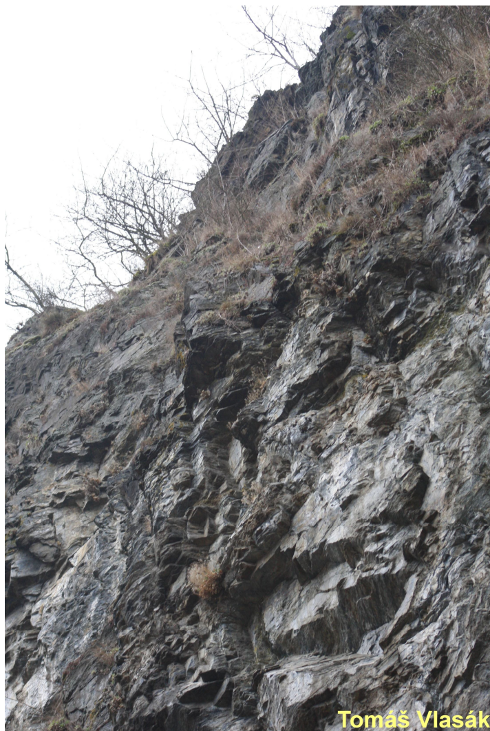
Obr.4 Skalní římsy a výstupky na Krkavčí skále
