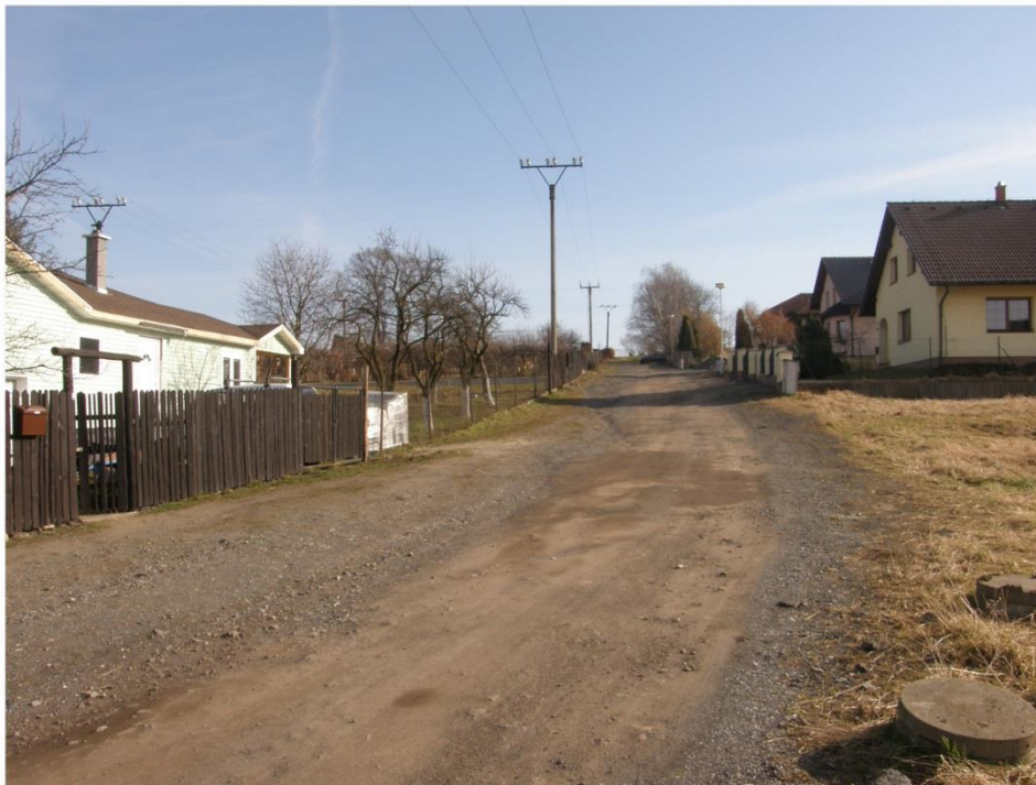
① ULICE U ZAHRAD: - NOVĚ BUDOVANÁ ULICE - SOUSTAVA RODINNÝCH DOMKŮ - V PŘÍMĚSTSKÉ ČÁSTI ŽILINA
