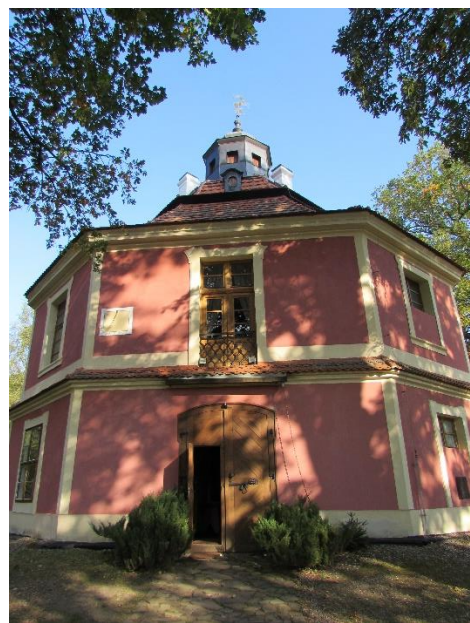
14) Jižní strana fasády zámku Sv. Hubert
