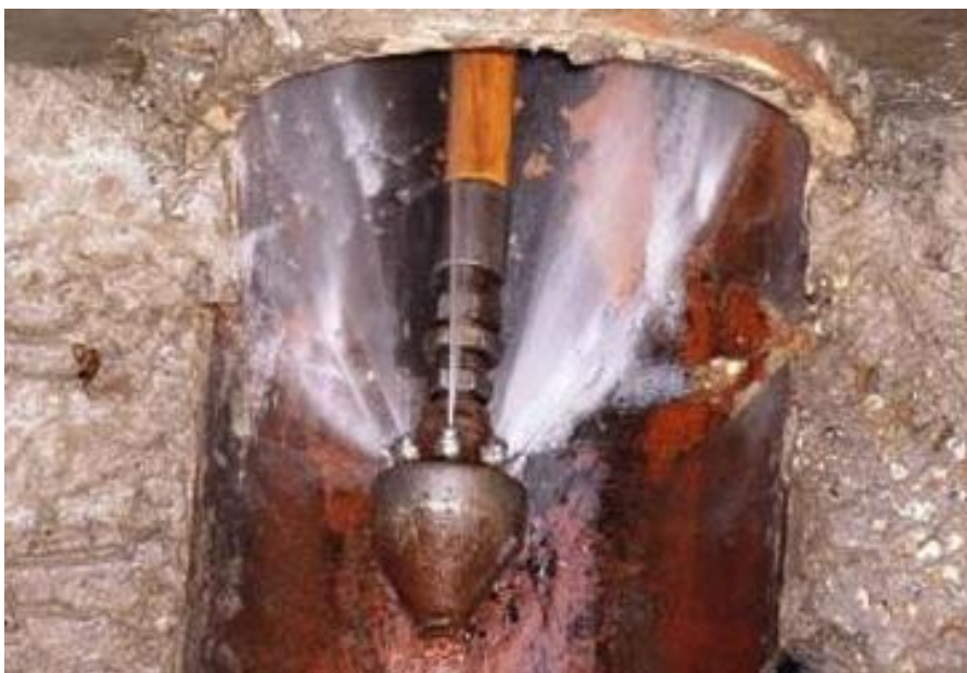
Obr. č. 5 Čištění propustku (kanalizace Frýdl s.r.o., 2016)
