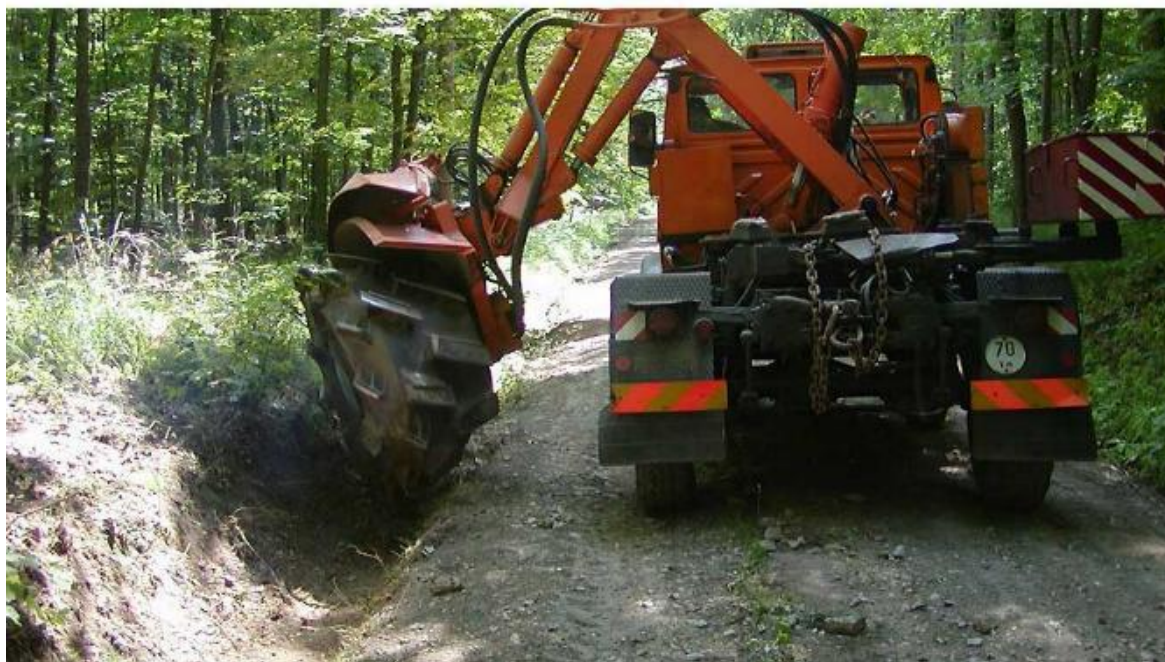
Obr. č. 3 Čištění a hloubení příkopů (CD služby s.r.o., 2016)
