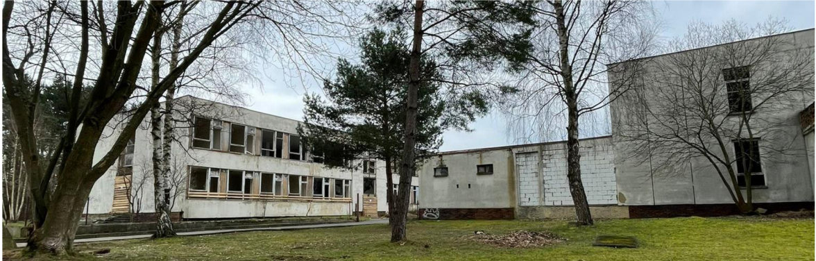
Obrázek 13 Bývalá škola a bytové jednotky – přestavba bytových jednotek v oblasti Ploužnice
