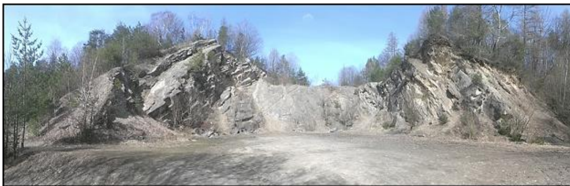
Obr. 14: Lom Chvalčov s dobře viditelnou vrstevnatostí pískovců a jílovců.
