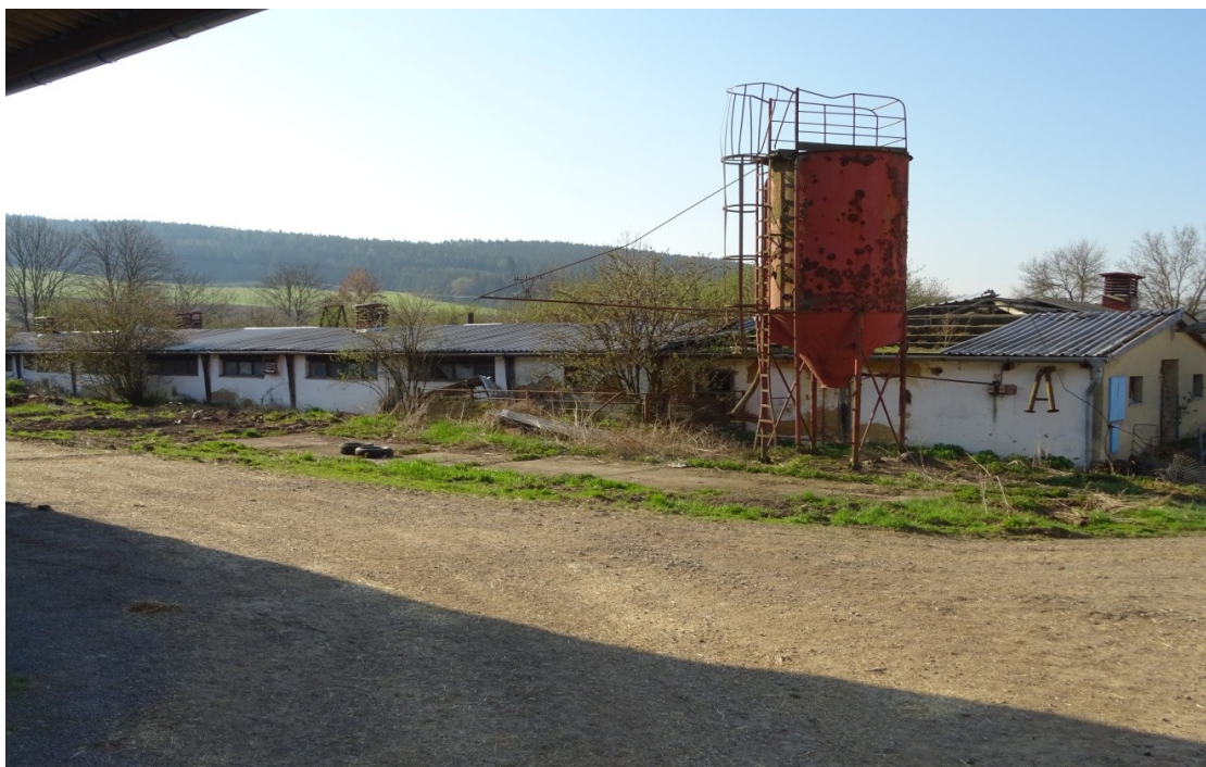
Příloha 5 Stará budova v Uhřicích - zde probíhal chov prasat
