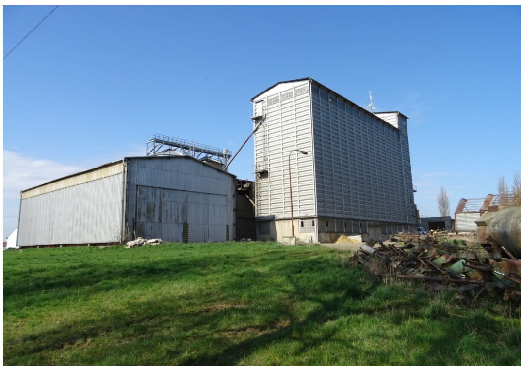
Příloha 12 Sušárna v Kninicích
