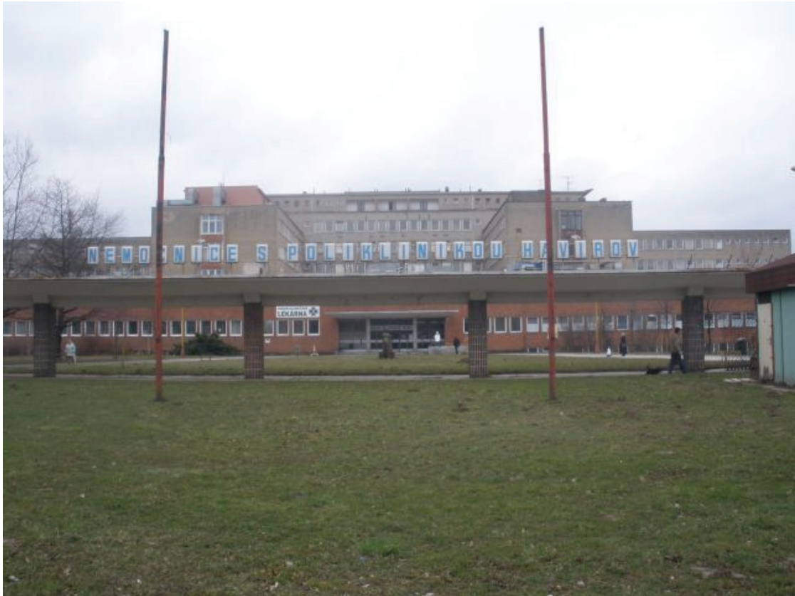
Obr. 1.9 Dalkia Česká republika, a.s. - Nemocnice Havířov (foto P. Kokoruda)
