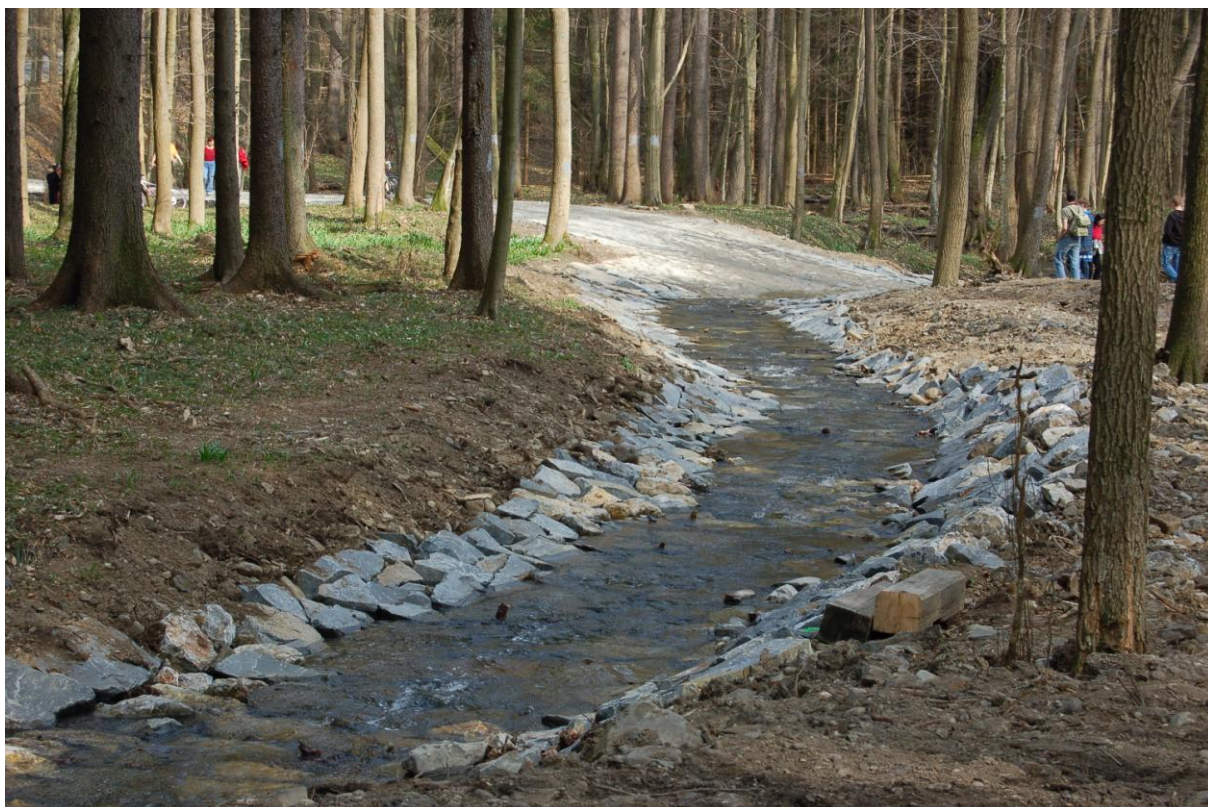
Obr. 5: Upravené koryto potoka Rakovce (foto: B. Šenková, 3. 4. 2011)
