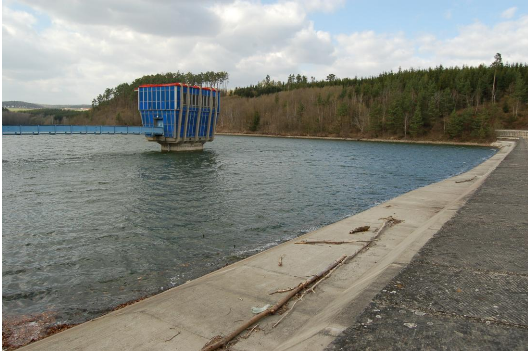
Obr. 6: Opatovická přehrada (foto: B. Šenková, 9. 4. 2011)
