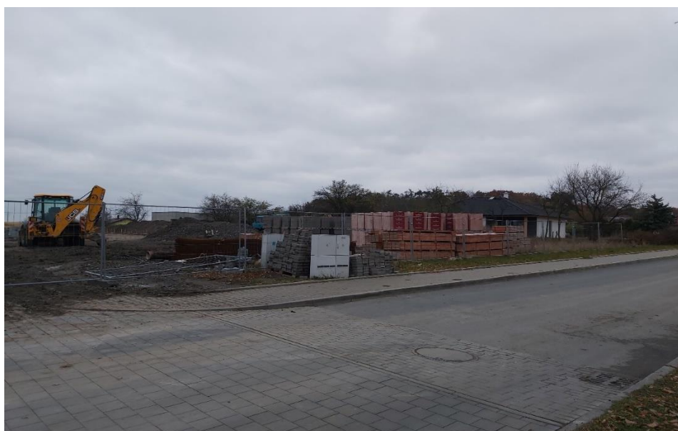
Obrázek 7: Výstavba Kolín V – Vinice
