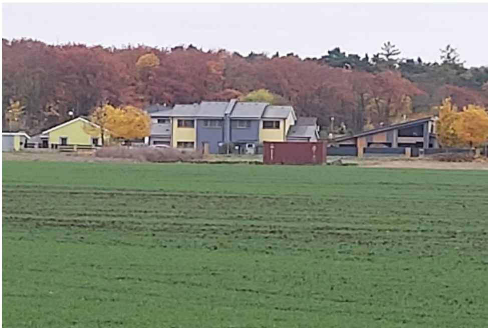
Obrázek 9: Výstavba Hradištko (pohled z Kolína)
