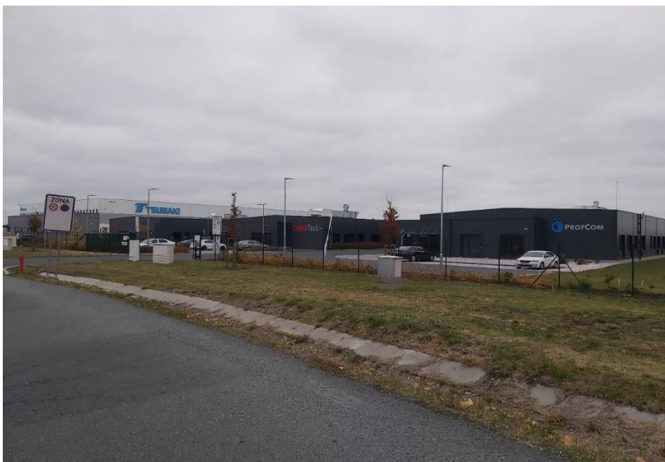
Obrázek 17: Průmyslová zóna Ověčáry – ControlTech a ProfCom
