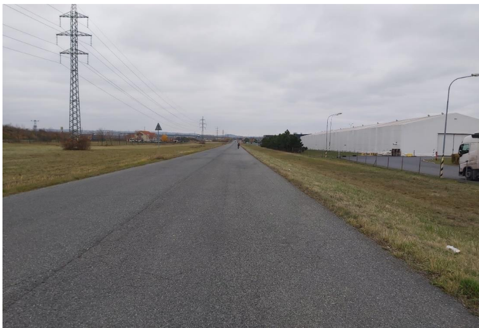
Obrázek 14: Průmyslová zóna Ověčáry – spojovací komunikace
