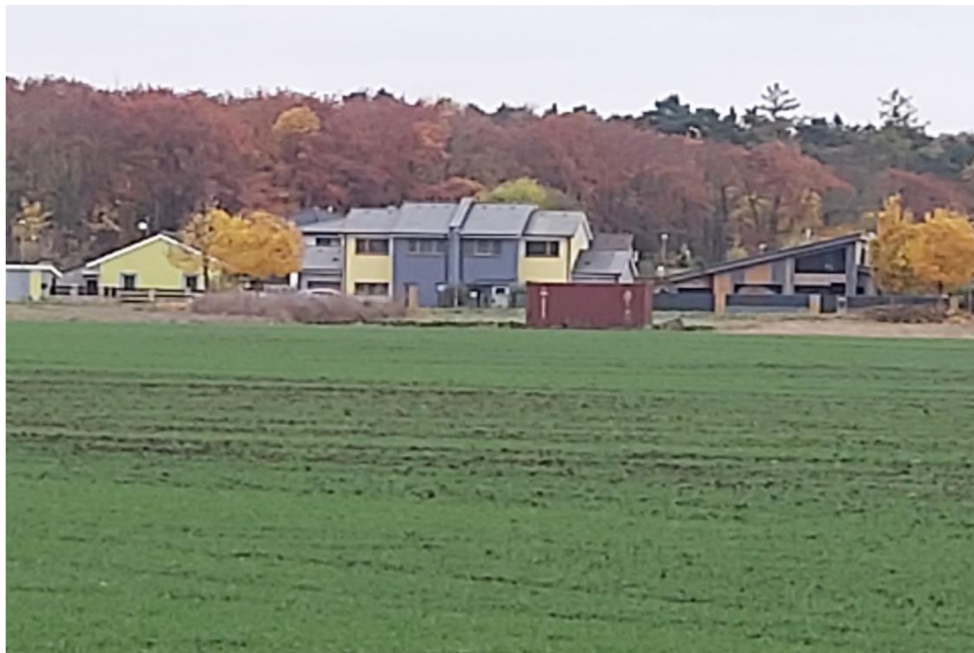
Obrázek 9: Výstavba Hradištka (pohled z Kolína)
