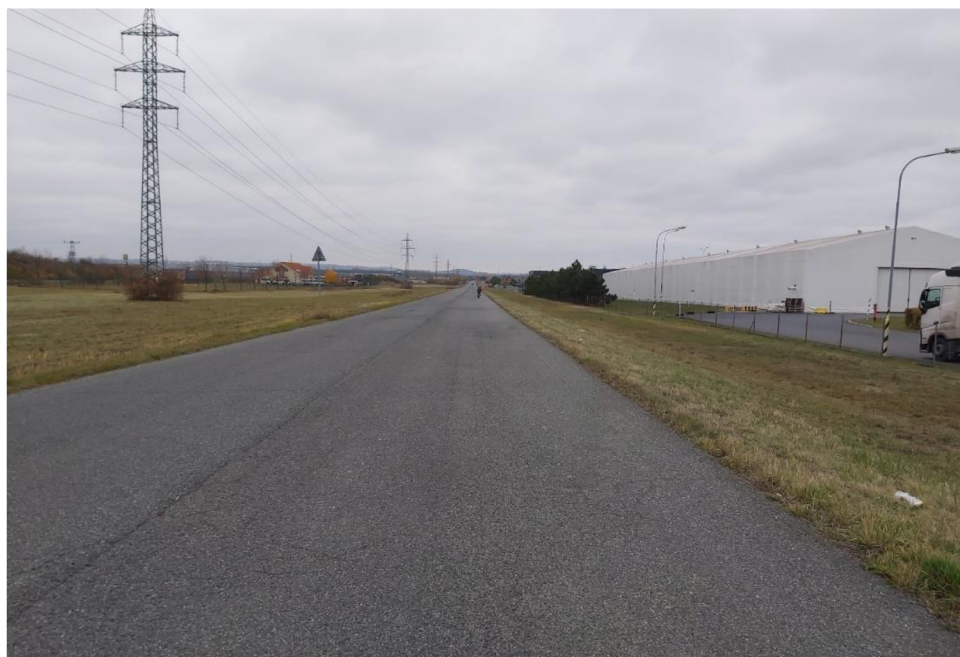
Obrázek 14: Průmyslová zóna Ověčáry – spojovací komunikace
