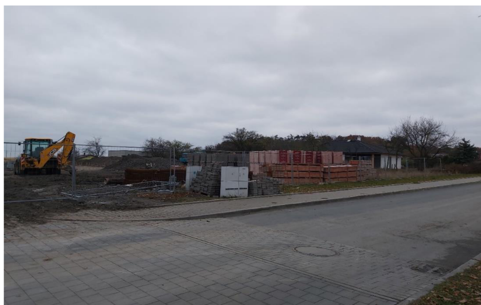
Obrázek 7: Výstavba Kolín V – Vinice
