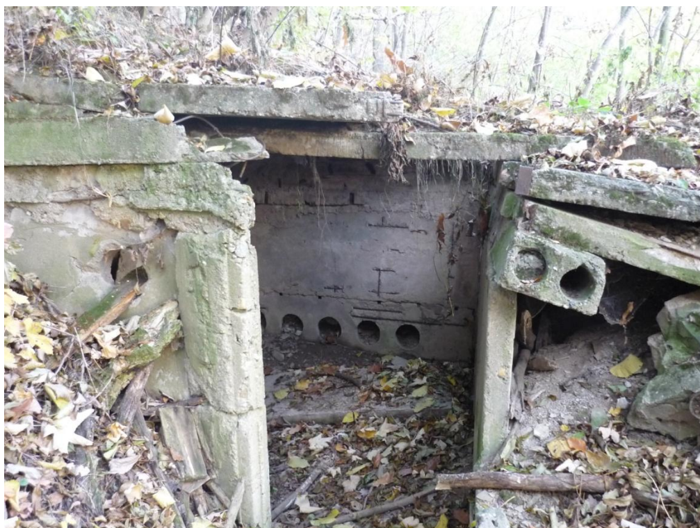
Obr.4: Bývalý betonový sklad munice
