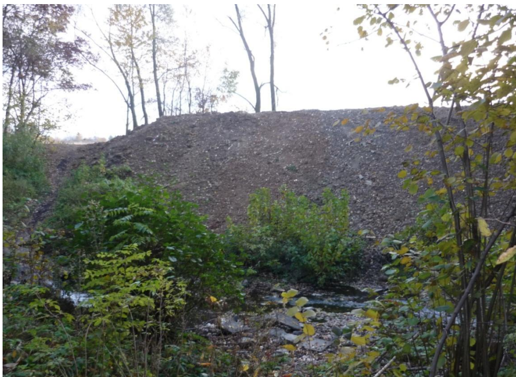
Obr.5: Navezená hlína z výkopů a zasypané stromy
