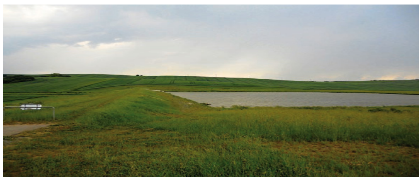
Obr. 9 Ochranná nádrž, (foto: VÚMOP)
