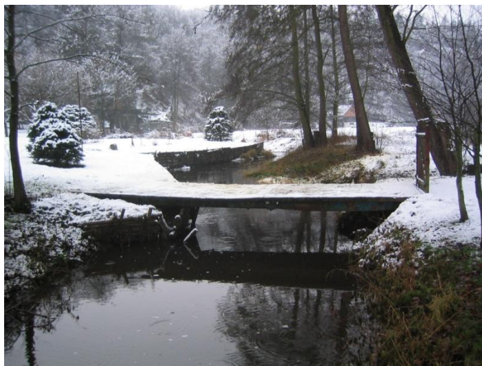
Foto. 5 Lávka pohled z východu na západ
