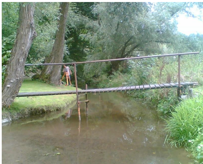
Foto. 10 Lávka pohled z jihu na sever
