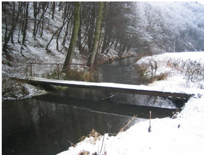
Foto. 17 Lávka pohled z východu na západ
