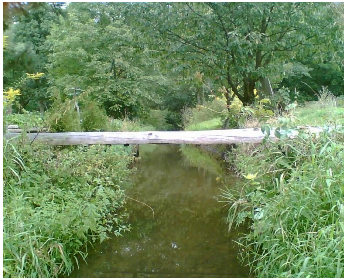
Foto. 13 Lávka pohled z jihu na sever
