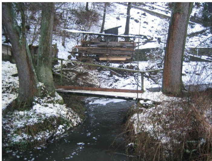
Foto. 6 Lávka pohled z východu na západ
