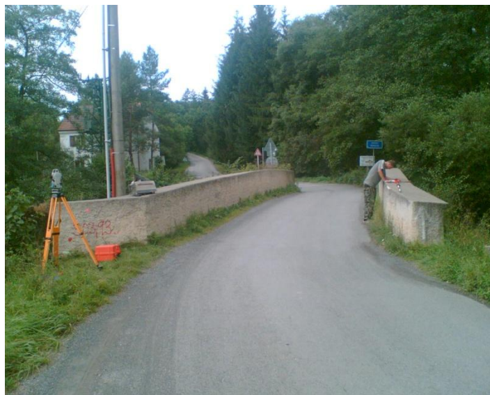
Foto. 4 Silniční most pohled z východu na západ
