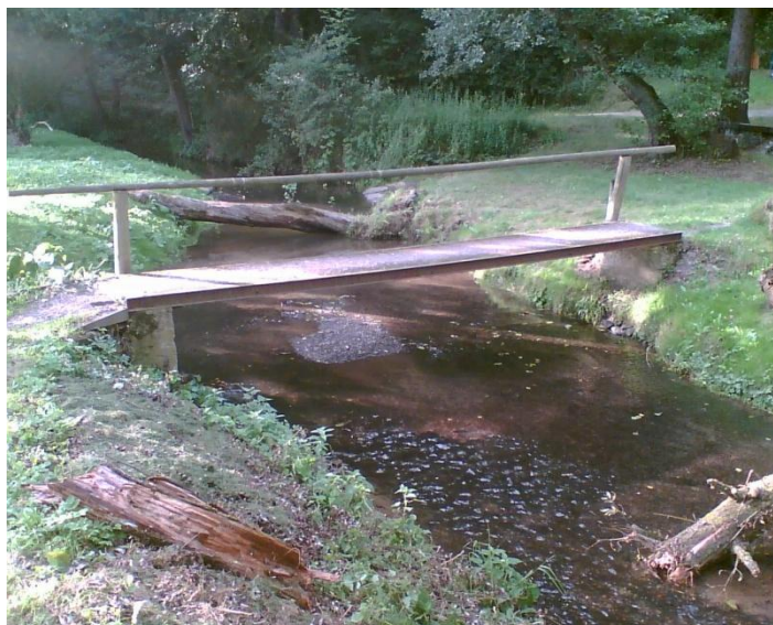
Foto. 14 Lávka pohled z jihu na sever
