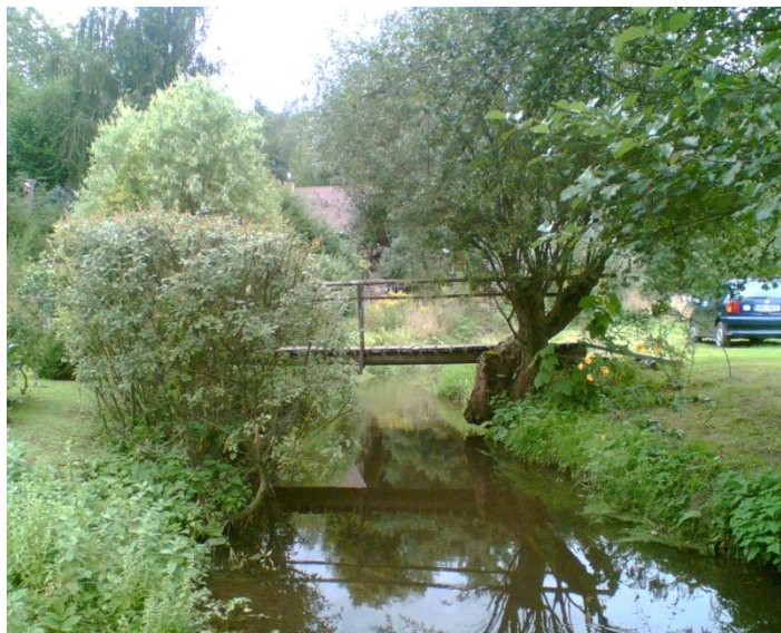
Foto. 12 Lávka pohled z jihu na sever
