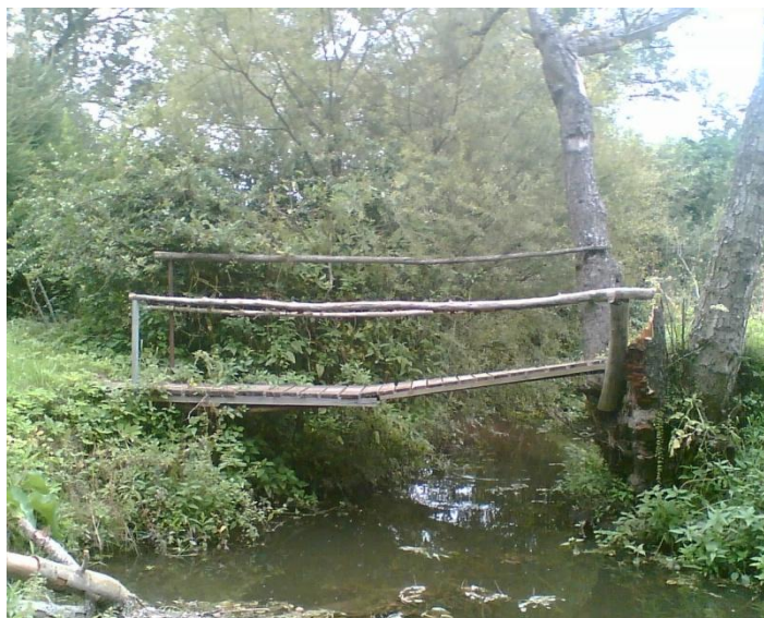
Foto. 9 Lávka pohled z jihu na sever
