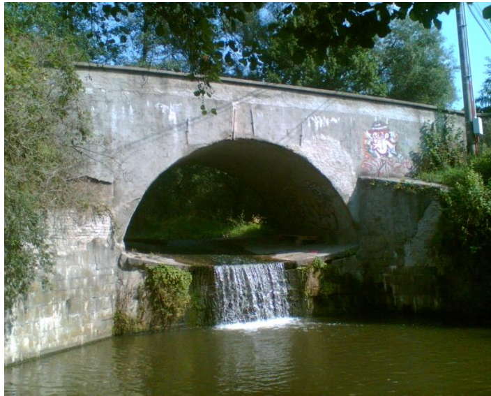
Foto. 3 Silniční most pohled z jihu na sever
