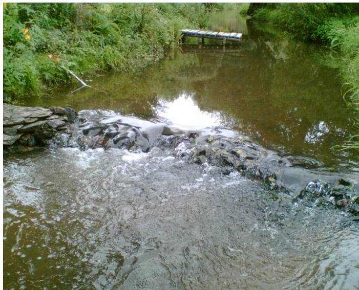
Foto. 11 Jez pohled z jihu na sever
