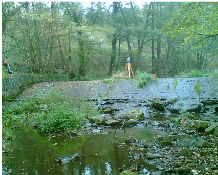
Foto. 1 Jez pohled z jihu na sever
