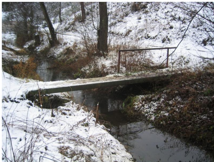
Foto. 16 "Lávka pohled z východu na západ
