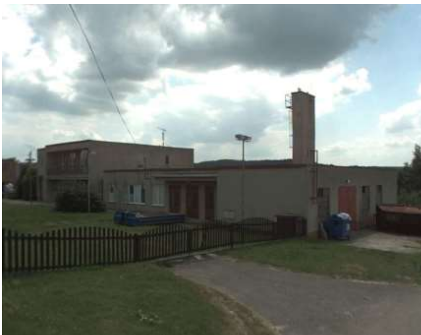
Obrázek 2.1 Budova mateřské školy ve Vedrovicích
