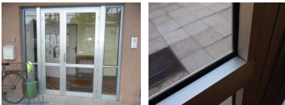
Obrázek 2.5 Vchodové dveře – dveře kovové s jedním sklem
