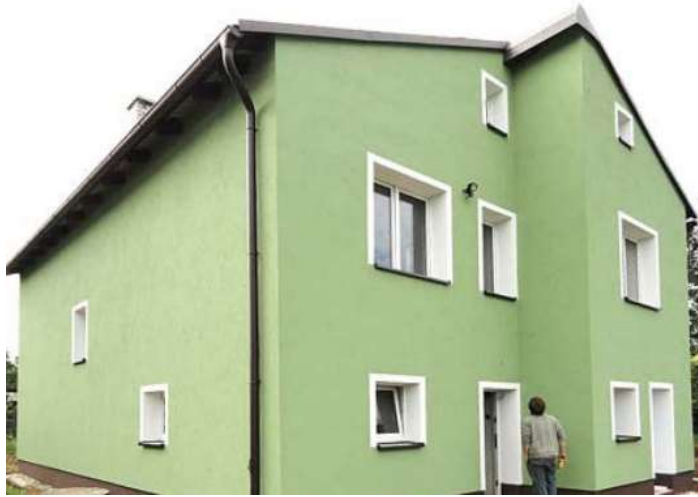
Obrázek 1.31 Optické porovnání velikosti okenních otvorů na vliv solárních zisků; zdroj časopis DEKTIME, ročník 2015
