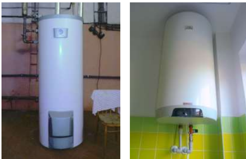
Obrázek 2.11 Nepřímotopný ohřívač vody De Ditrich BPB 300, přímotopný ohřívač Dražice OKCE 125
