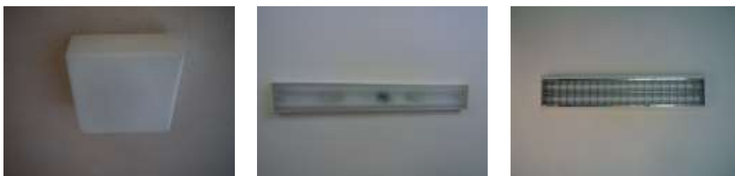
Obrázek 2.12 Osvětlení – klasické žárovky, lineární zářivky
