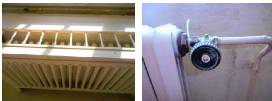
Obrázek 2.10 Otopné těleso článkové v dětské herně a regulace otopných těles
