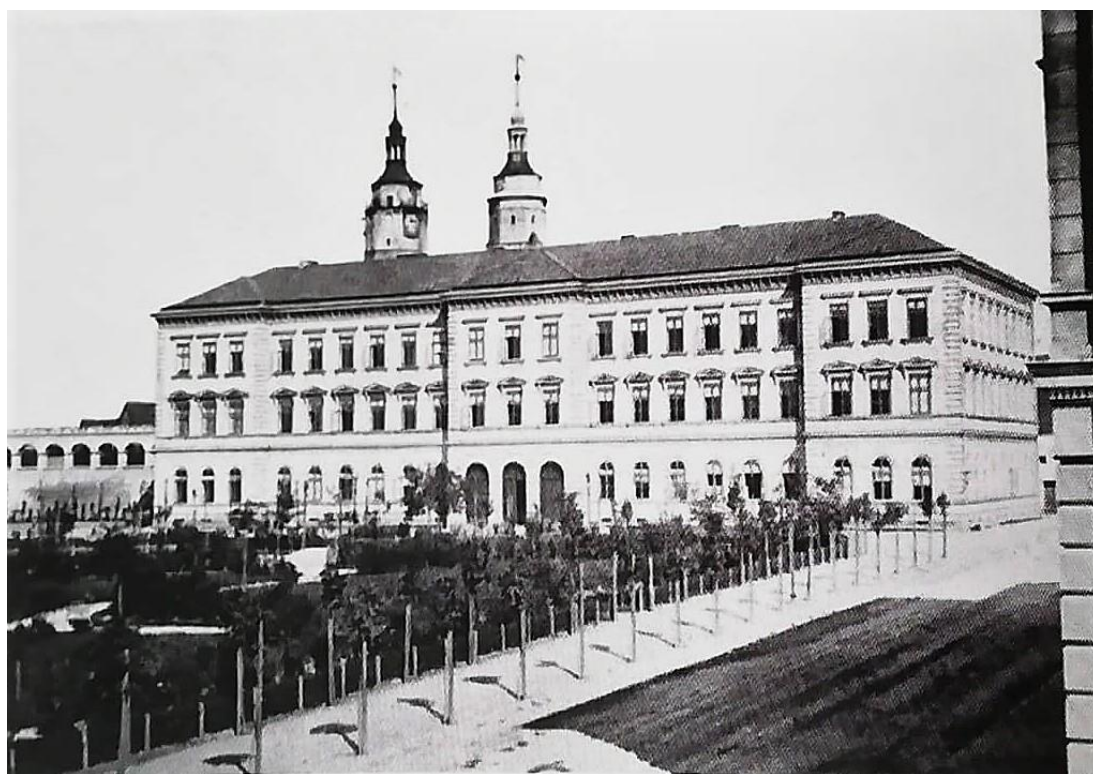
Obrázek 4 – Budova vyšší reálky postavená a projektována krnovským stavitelem J. Hartlem v letech 1875–1877.
