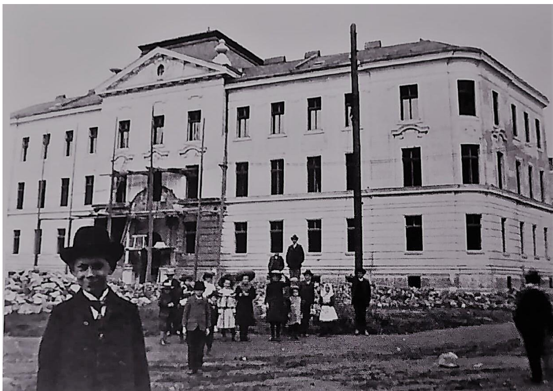
Obrázek 6 – Dokončování stavby budovy okresního hejtmanství z roku 1906.
