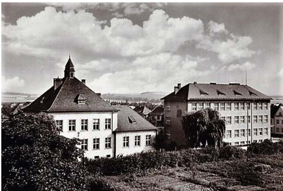
Obrázek 8 – Historická fotka budovy na Jiráskově ulici.
