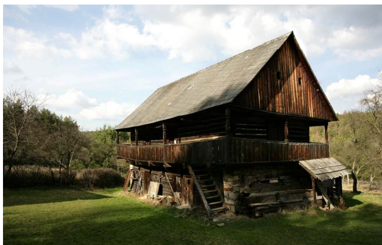
Obrázek č. 24: Celodřevěné obytné stavení v Radějově
