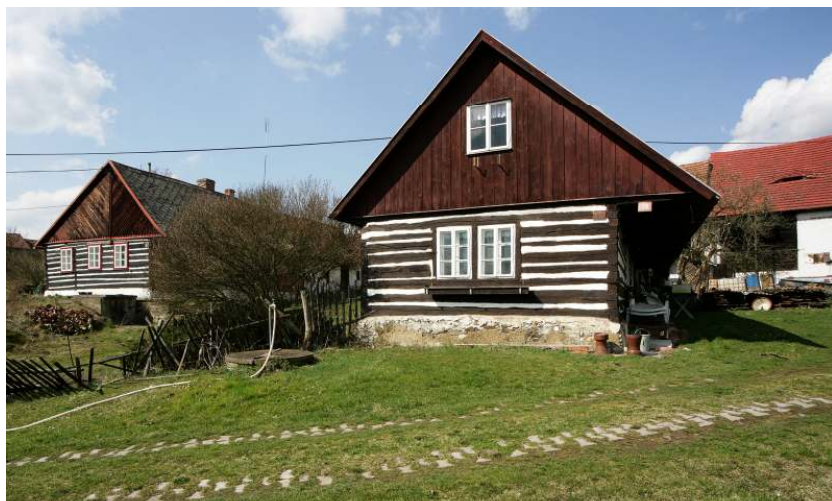
Obrázek č. 22: Roubená obytná stavení ve Lhotě u Chříče
