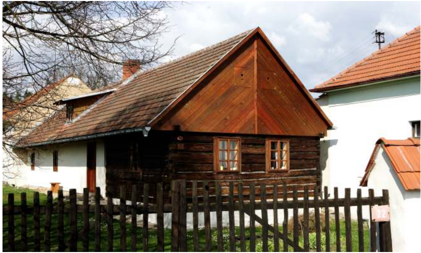
Obrázek č. 13: Roubené obytné stavení trojdílné dispozice
