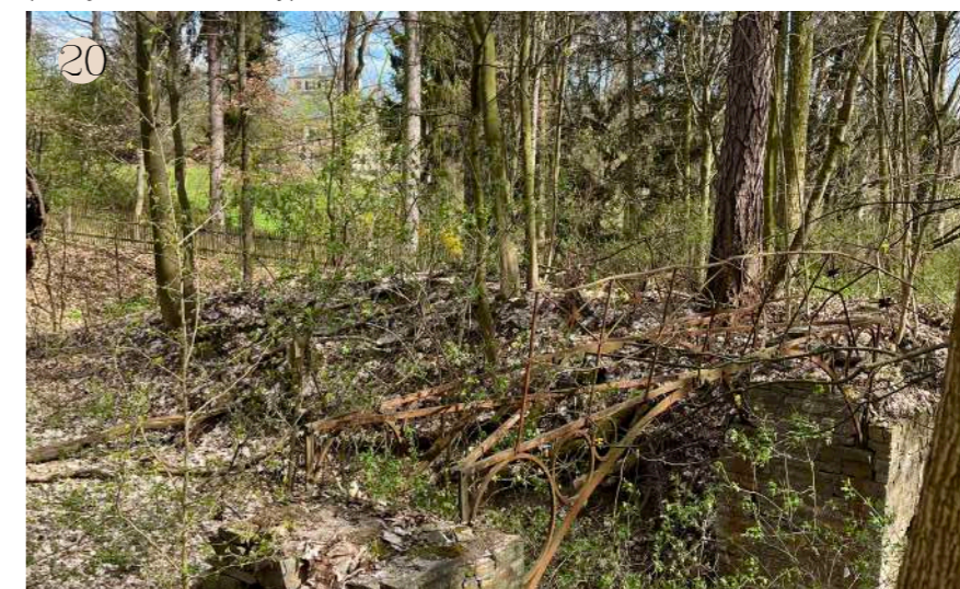
Obr. 124: Železná lávka, která původně propojovala bažantnici a zámecký park, zřejmě s průhledem k zámku (zdroj: archiv autorky)
