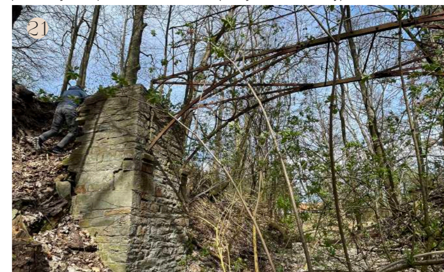
Obr. 125: Železná lávka (zdroj: archiv autorky)
