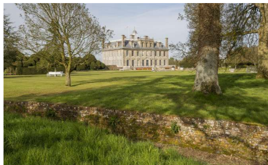
Obr. 10: Ha-ha příkop (zdroj: nationaltrust.org.uk)
