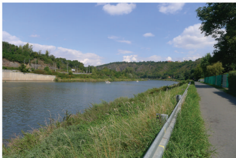
FOTOGRAFIE STÁVAJÍCÍHO STAVU SEKCE A
