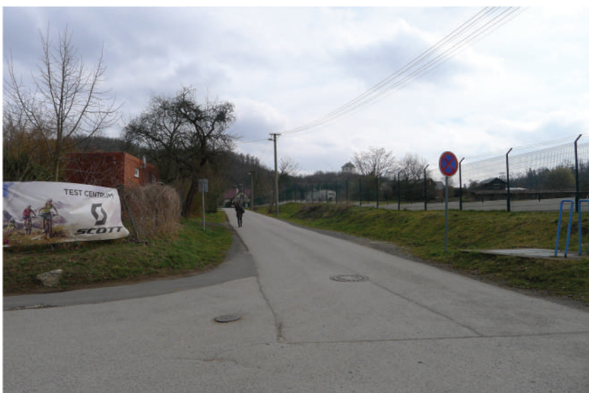
Pohled na hlavní severní příjezd do řešené zóny. Cyklostezka není nijak vizuálně oddělena od místní komunikace. Chybí ukazatel blízké autobusové zastávky.
