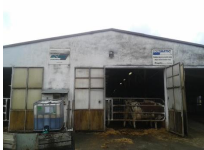
Obrázek 30 – Přední štítová stěna s železnými vraty s dřevěnou výplní.
