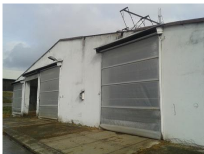
Obrázek 31 – Zadní štítová stěna s rolovacími vraty od značky BCB Technik.
