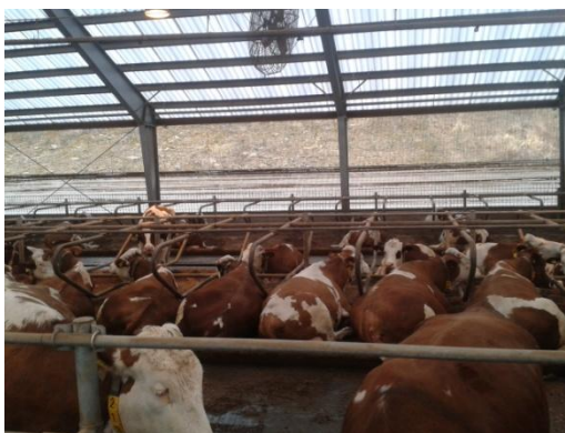
Obrázek 32 – Ocelové, flexibilní zábrany společnosti Agromont Vimperk na Školním statku v Humpolci.
