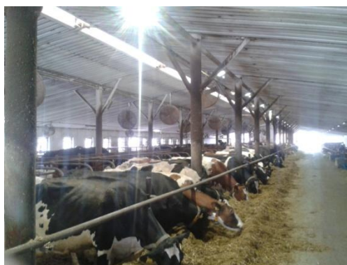
Obrázek 29 - Trojlodní ocelová konstrukce ZOD Hořice.
