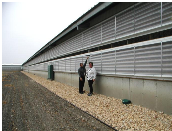
Obrázek 12 – Pneumaticky ovládané stěny JanAire
