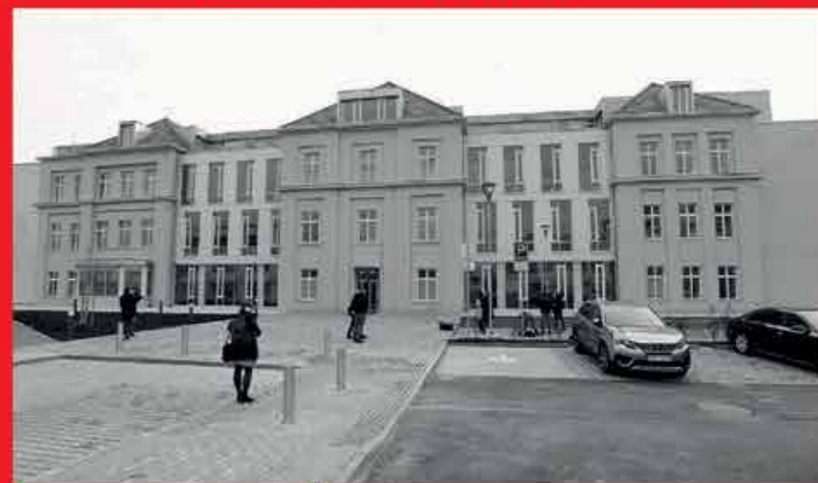
rekonstruovaný Bakešův pavilon, Ing. arch. Vladislav Vrána, 2021
