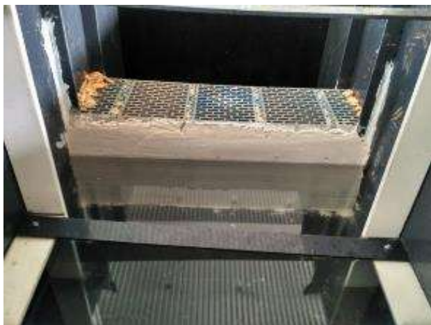
Obr. 3 Lícová strana konstrukce z mokré strany po 14 dnech zatížení vodou
