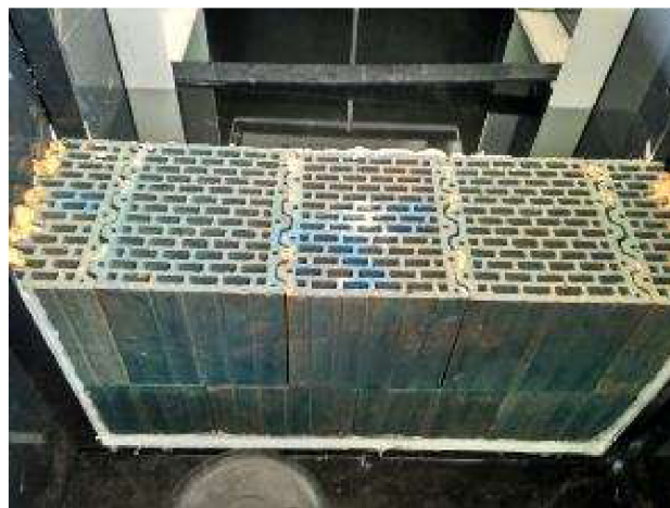
Obr. 4 Lícová strana konstrukce ze suché strany po 14 dnech zatížení vodou
