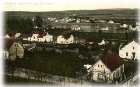
Obr. 32: Pohled z Lysin na jihovýchod v roce 1917 (Beranová, 2009)
