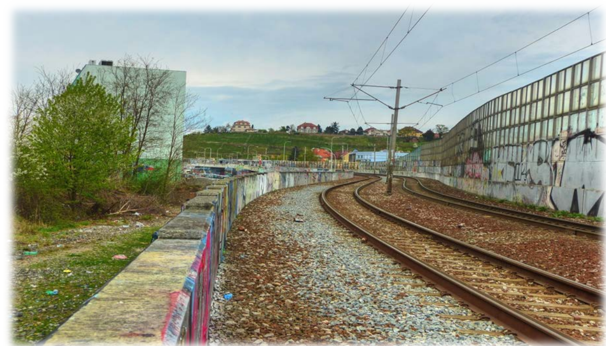
Obr. 69: V současné době vede na místě tramvajová doprava (Autor, 2014)
