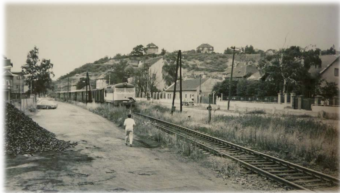
Obr. 68: Původní železniční trať, kde byla zříčená zastávka "Modřany-Městys" (Beranová a Kňap, 2014)
