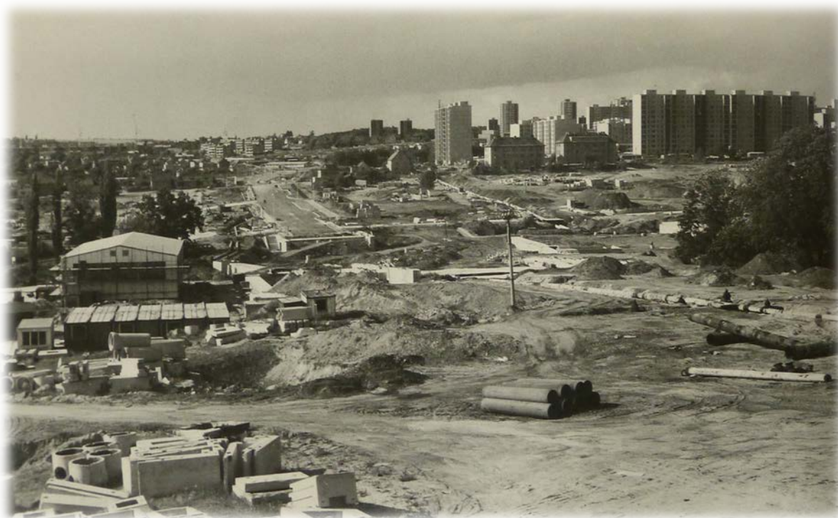
Obr. 60: Fotografie z 80 let zachycuje výstavbu Sofijského náměstí a teplárny (Beranová a Kňap, 2014)
