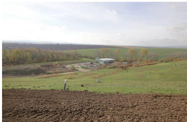
Obrázek č. 1 Skládka odpadů Němčice nad Hanou [22]
