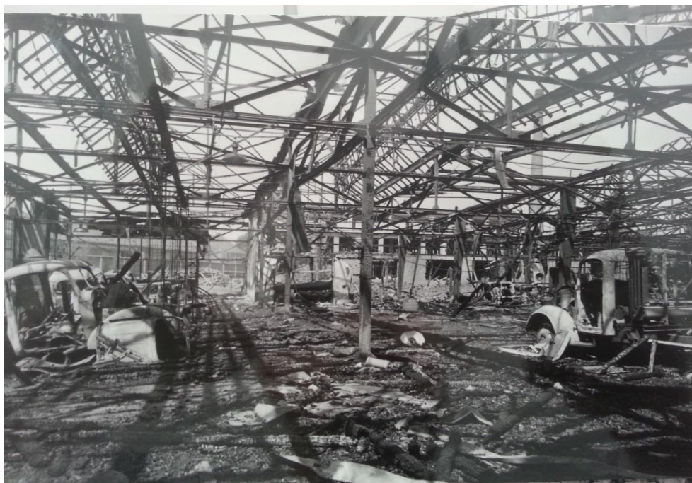
Vnitřek jedné z hal po náletu a požáru 9.5. 1945 (zdroj: Archiv společnosti Škoda Auto, fond ASAP č. 50 - Požáry, bombardování)
