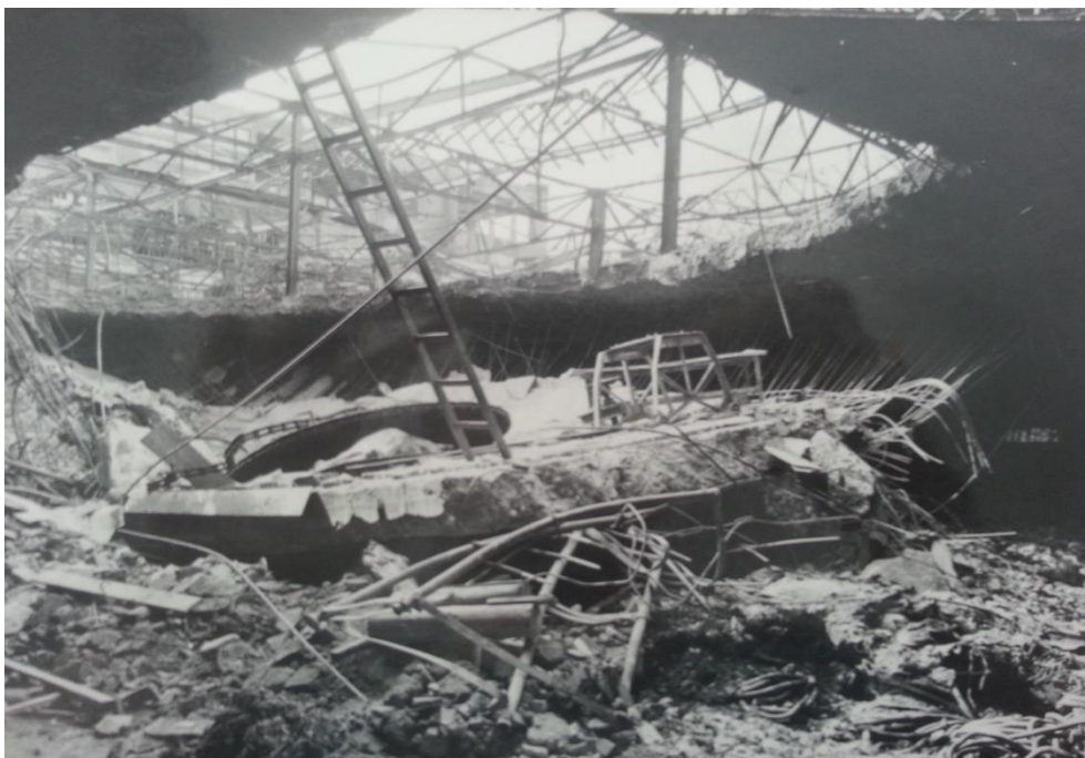
Snímek propadlého stropu (zdroj: Archiv společnosti Škoda Auto, fond ASAP č. 50 - Požáry, bombardování)
