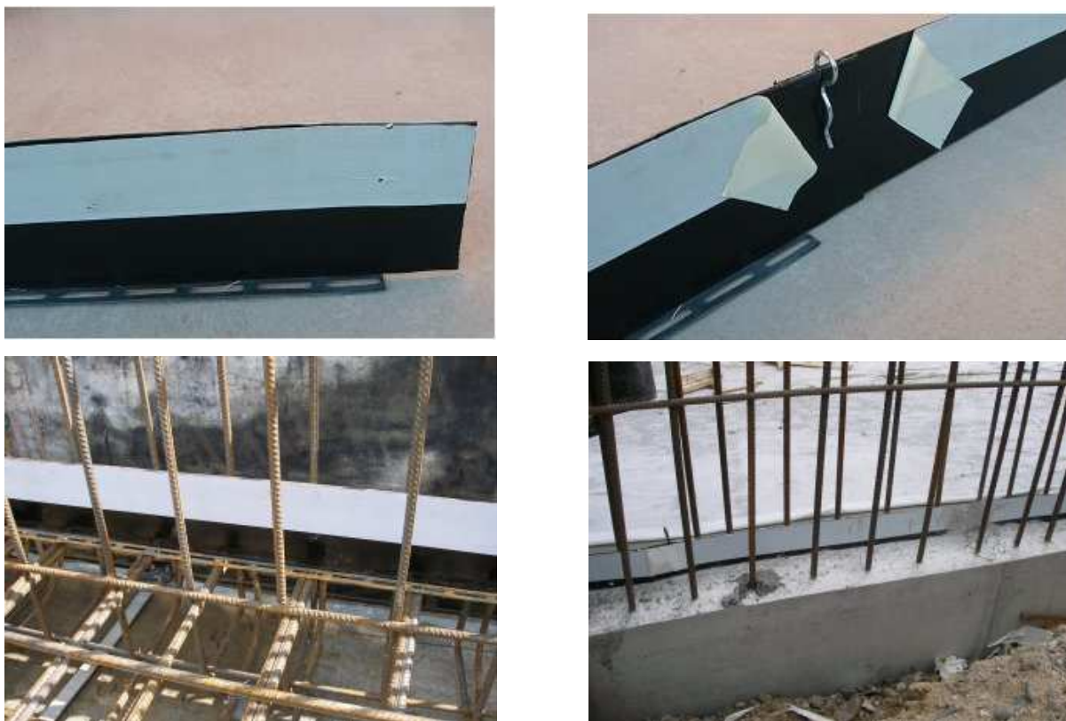
Obr. 10 - Uložení speciálního těsnícího plechu BK
