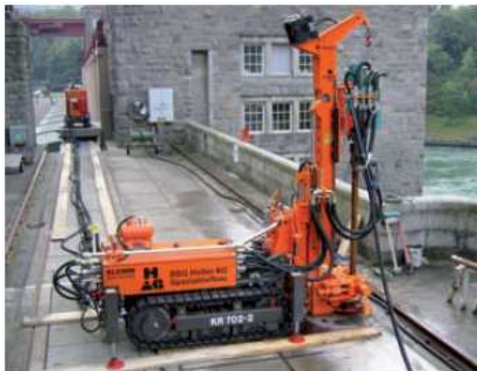
Obr. 29 - Vrtná souprava KELEMM KR 702-2
