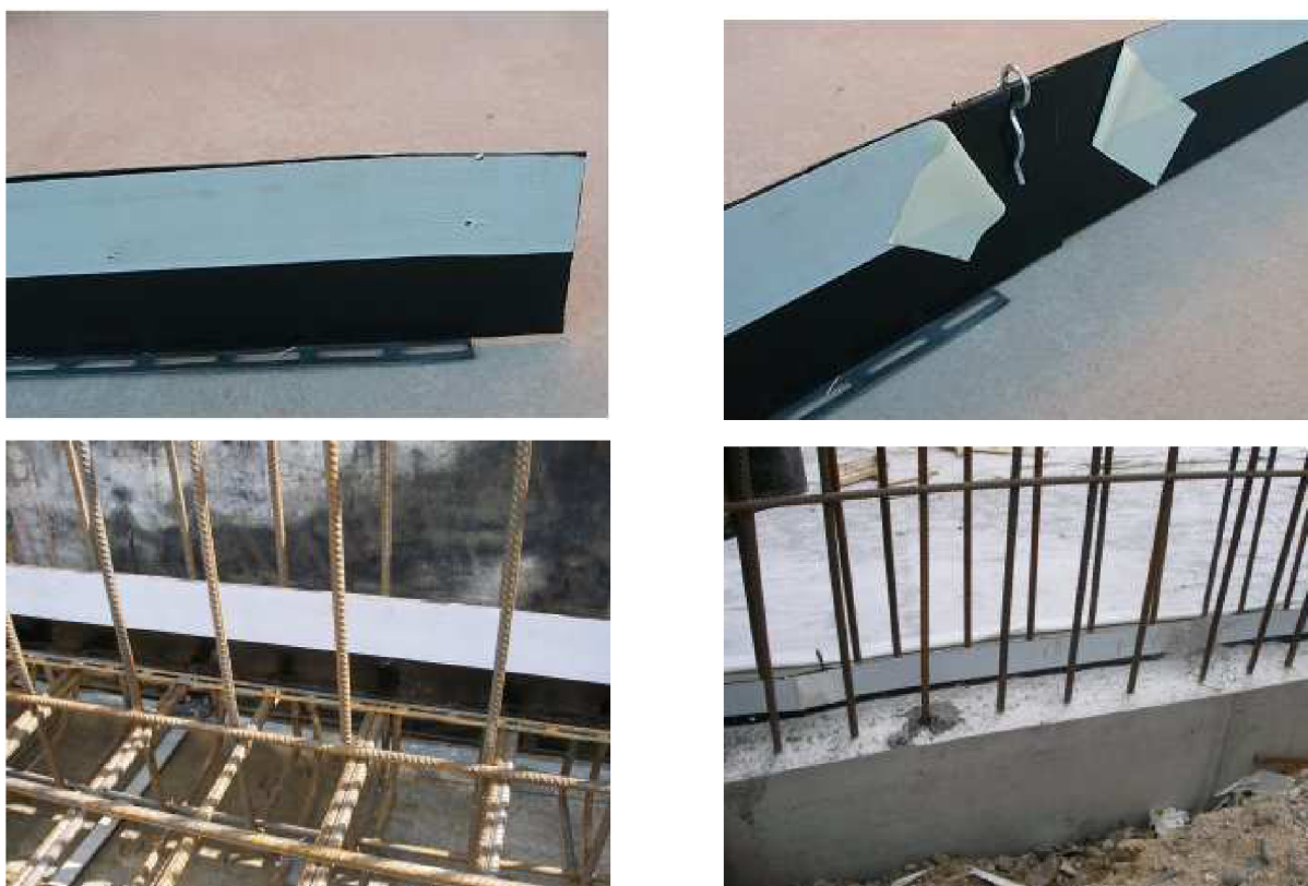
Obr. 10 - Uložení speciálního těsnícího plechu BK
