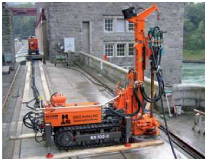
Obr. 29 - Vrtná souprava KELEMM KR 702-2
