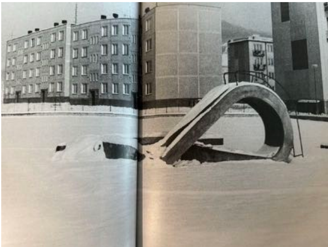
11. Mária Bartuszová, Detská preliezačka a šmýkačka v Materskej škôlke na Sládkovičovej ulici v Revúcej, 1969–1970, betón, cca 200 cm. Reprofoto: Gabriela Garlatyová (edd.), Mária Bartuszová , Rimavská Sobota 2021, s. 64.
