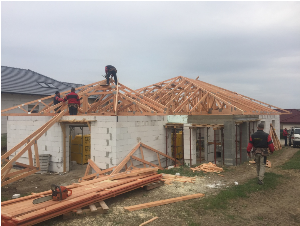
Obrázek 16. Montáž příhradových vazníků v Čejkovicích
