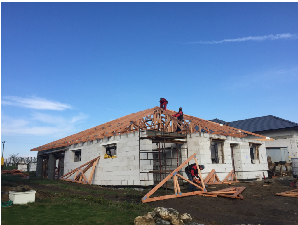
Obrázek 17. Montáž příhradových vazníků v Čejkovicích
