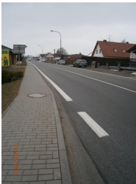
Obrázek 17-Chodník a hlavní komunikace v obci Štěpánovice (směr Třeboň)
