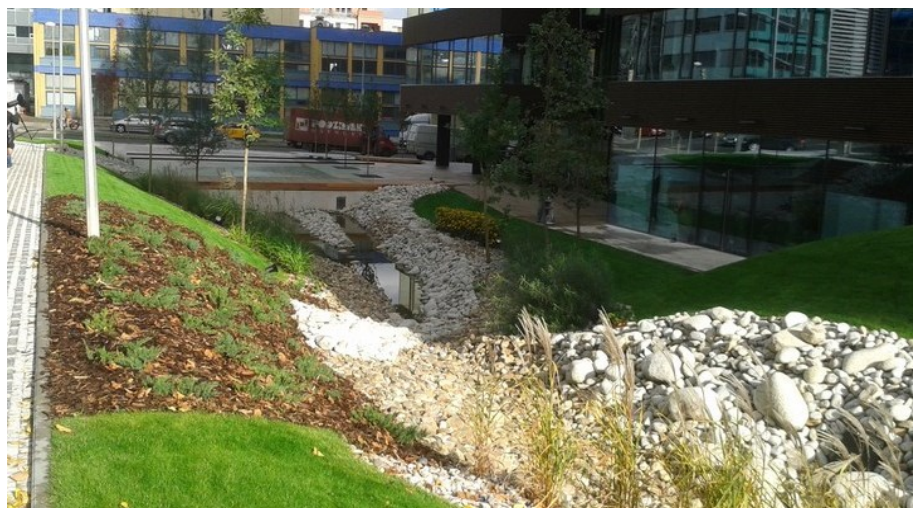
Obrázek 12: Retenční nádrž u budovy Delta v Praze Michly (Nehasilová, 2022)
