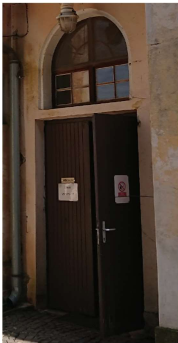
Obr. 28: Dveře objektu v terénu
