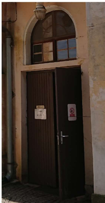
Obr. 28: Dveře objektu v terénu
