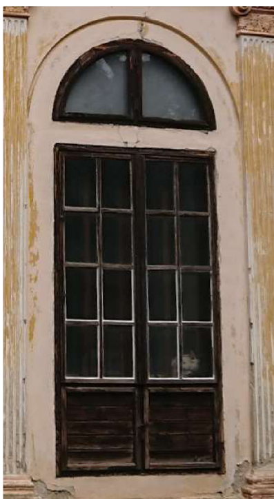
Obr. 24: Okno objektu v terénu
