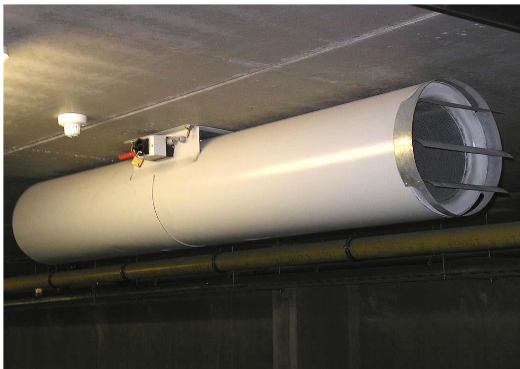
Obrázek 28 – Umístění požárního impulzního ventilátoru pod stropem [15]
