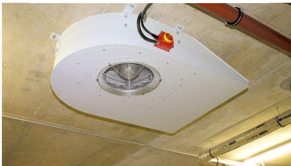
Obrázek 10 – Umístění indukčního ventilátoru pod stropem [16]
