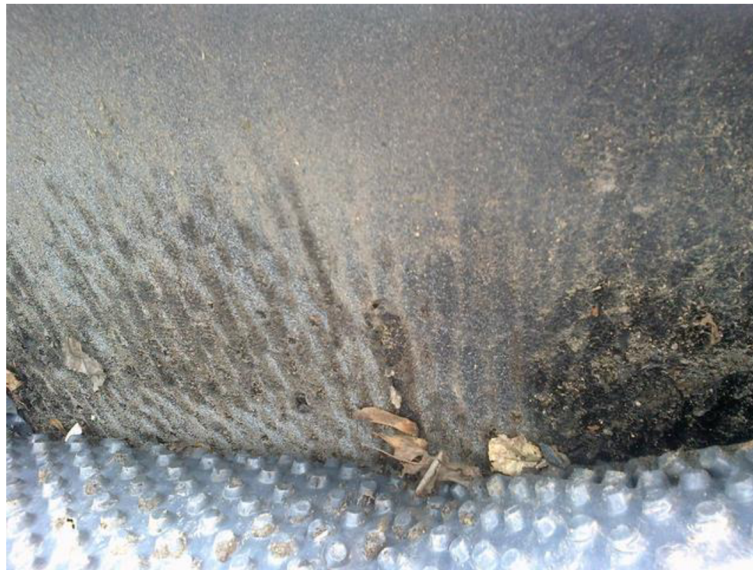
Obrázek 2-3: Poškození hydroizolace způsobené protlačení nopů vlivem hutnění
