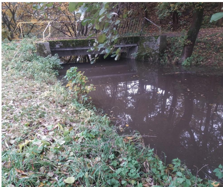
Obrázek 1: Propustek na začátku 1. úseku (Zdroj: Folprecht, 2020)
