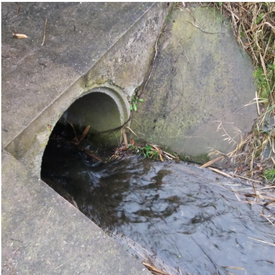
Obrázek 25: Propustek na 26. úseku (Zdroj: Folprecht, 2020)
