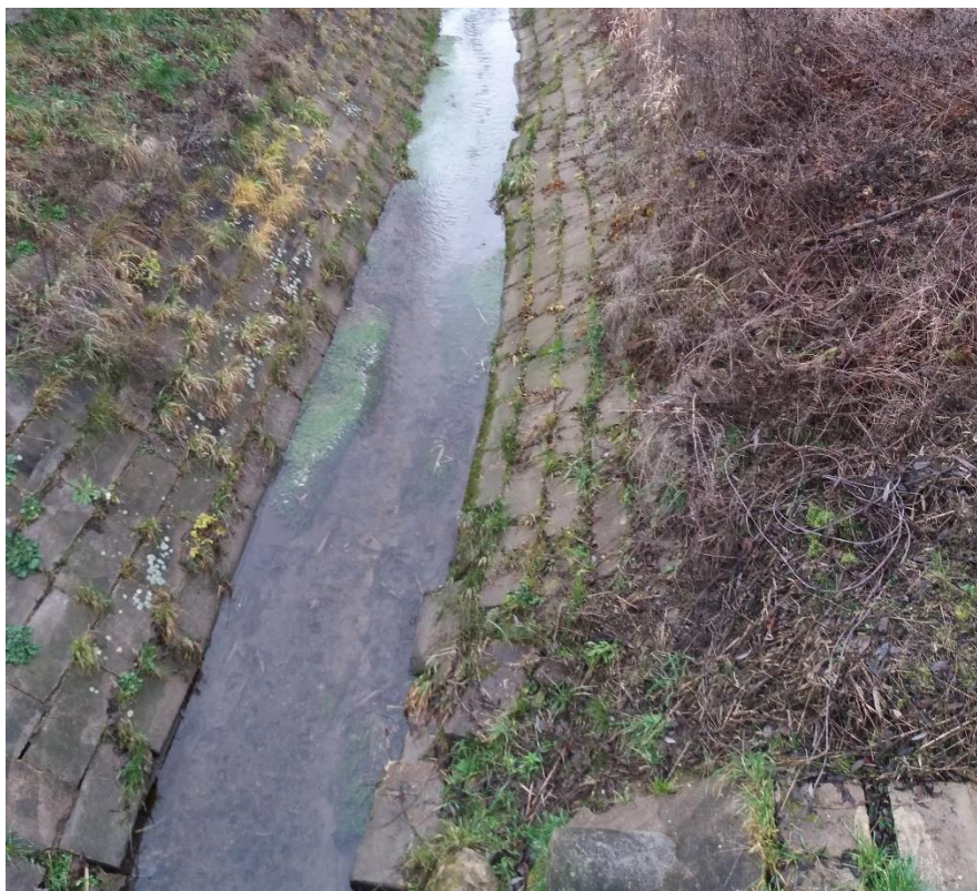
Obrázek 27: Lichoběžníkové koryto z betonových tvárnic na úseku č. 28 (Zdroj: Folprecht, 2020)
