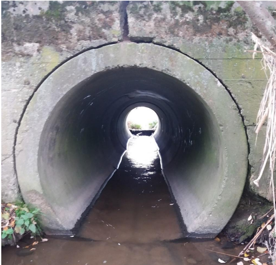
Obrázek 24: Propustek na 26. úseku (Zdroj: Folprecht, 2020)
