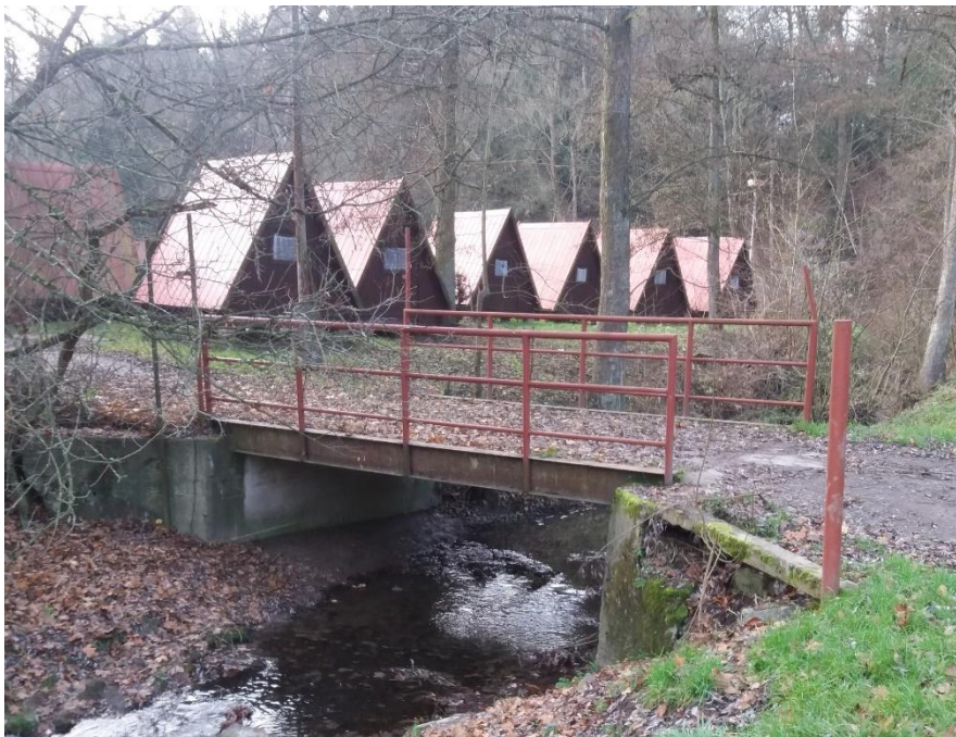
Obrázek 21: Propustek na konci 24. úseku (Zdroj: Folprecht, 2020)
