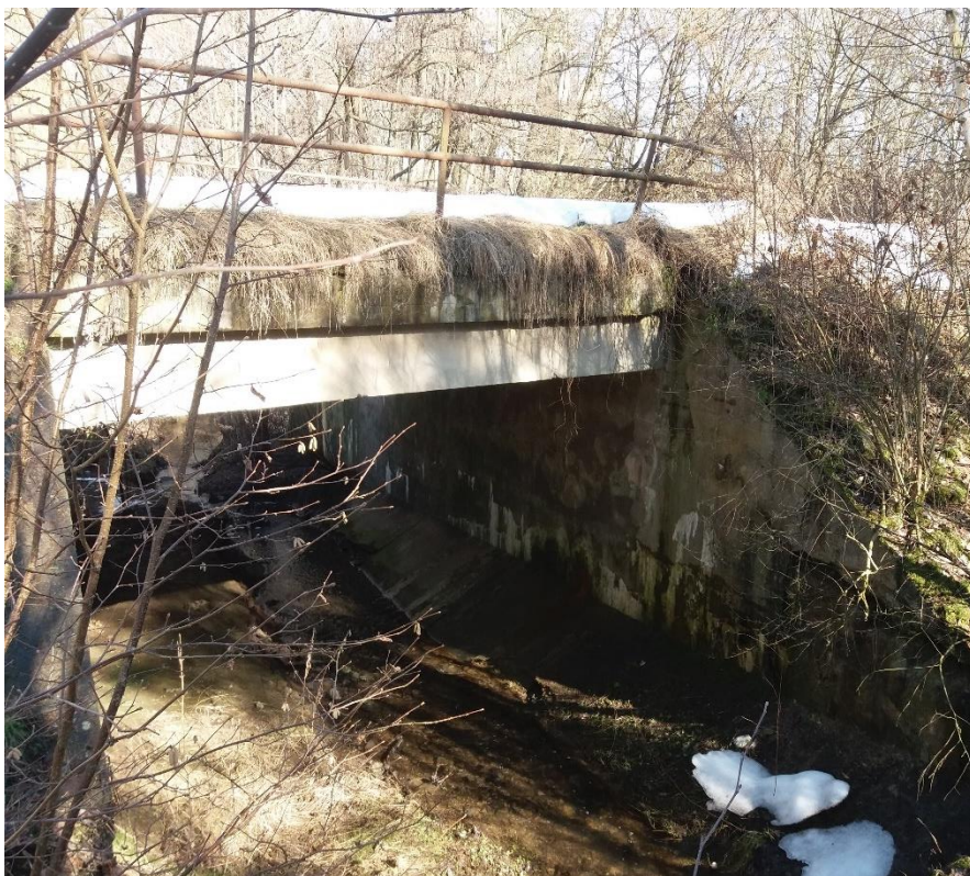
Obrázek 31: Propustek na konci 32. úseku (Zdroj: Folprecht, 2021)
