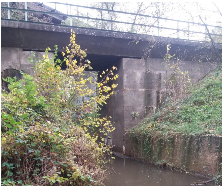
Obrázek 4: Železniční most, betonové koryto na 2. úseku (Zdroj: Folprecht, 2020)
