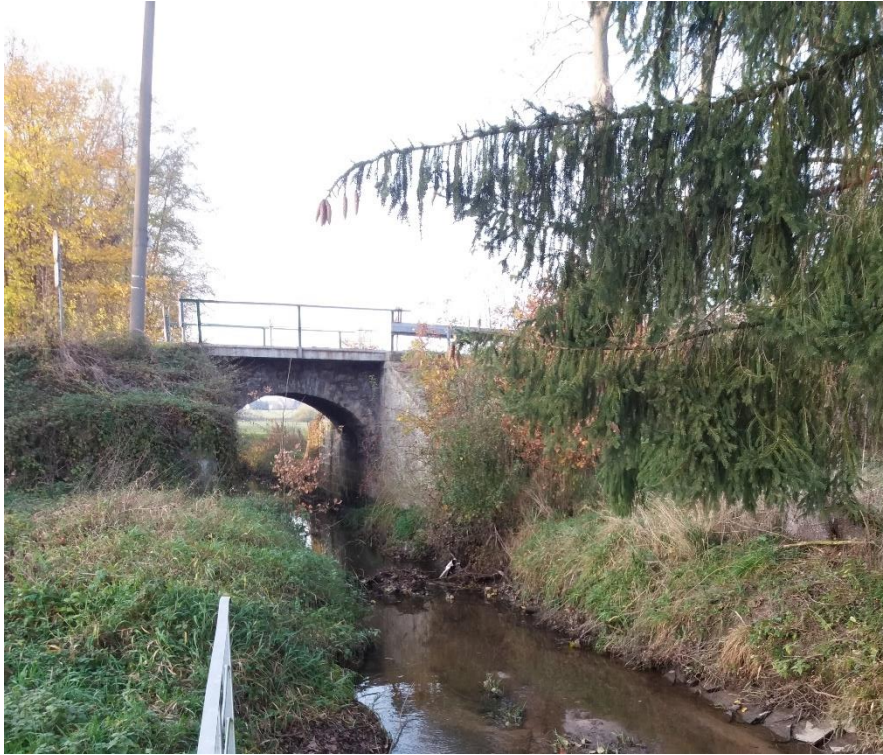
Obrázek 7: Silniční most na konci 4. úseku (Zdroj: Folprecht, 2020)
