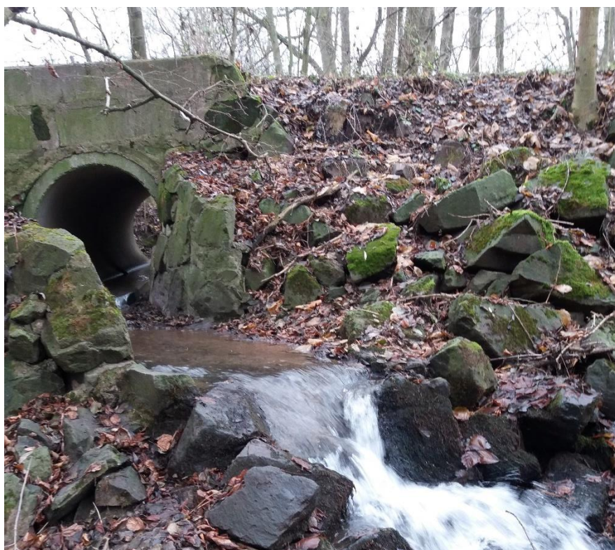
Obrázek 29: Propustek na 30. úseku (Zdroj: Folprecht, 2020)
