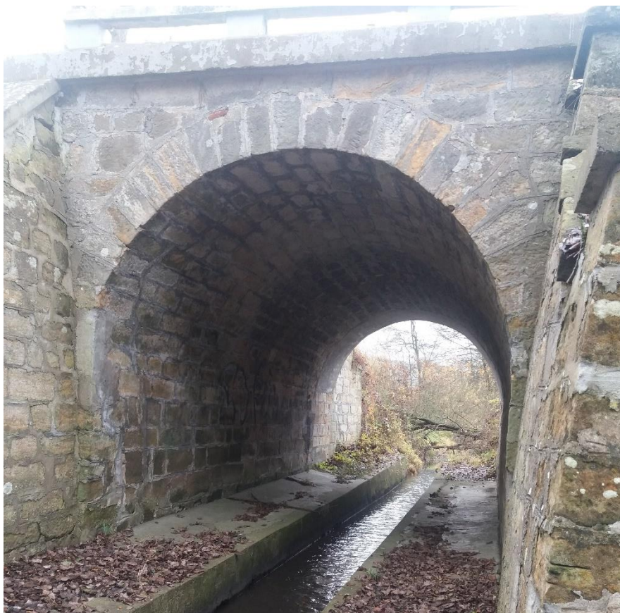
Obrázek 9: Silniční most na konci 6. úseku (Zdroj: Folprecht, 2020)
