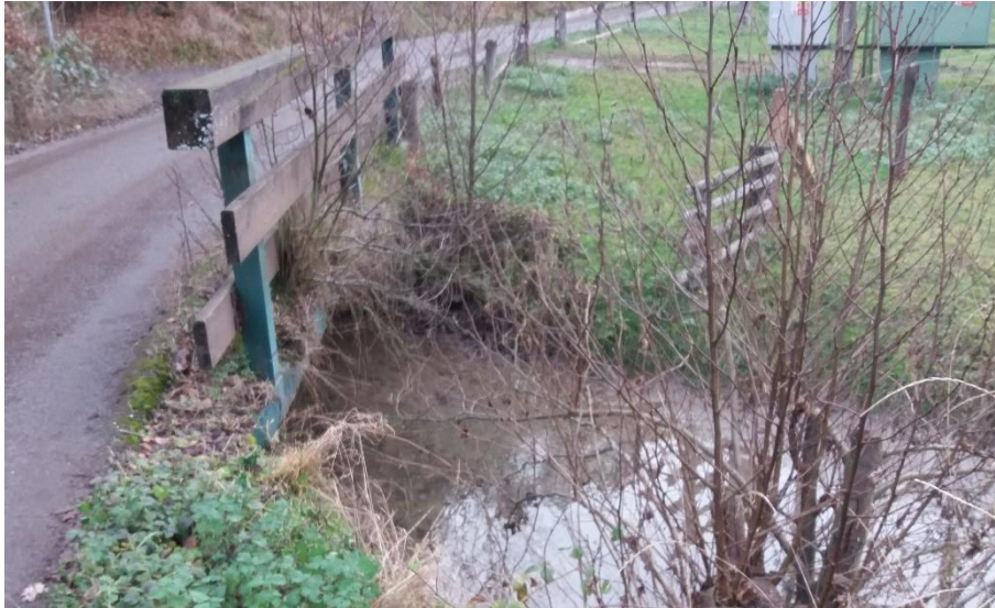
Obrázek 15: Propustek na konci 15. úseku (Zdroj: Folprecht, 2020)
