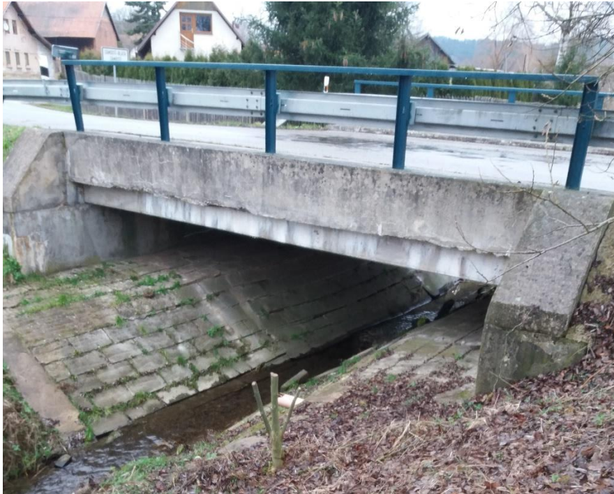
Obrázek 26: Silniční mostek na úseku č. 28 (Zdroj: Folprecht, 2020)
