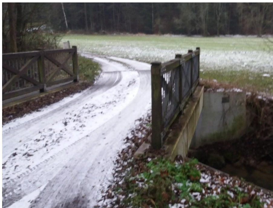
Obrázek 10: Propustek na 7. úseku nedaleko Vysokého Kola (Zdroj: Folprecht, 2020)
