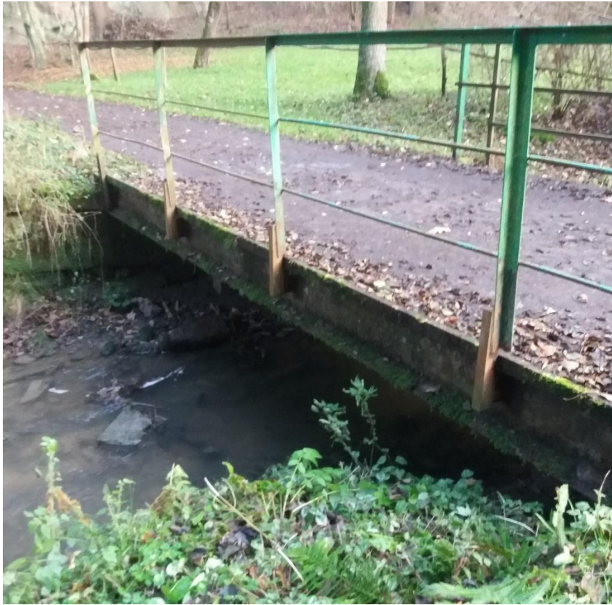
Obrázek 13: Propustek na 14. úseku (Zdroj: Folprecht, 2020)
