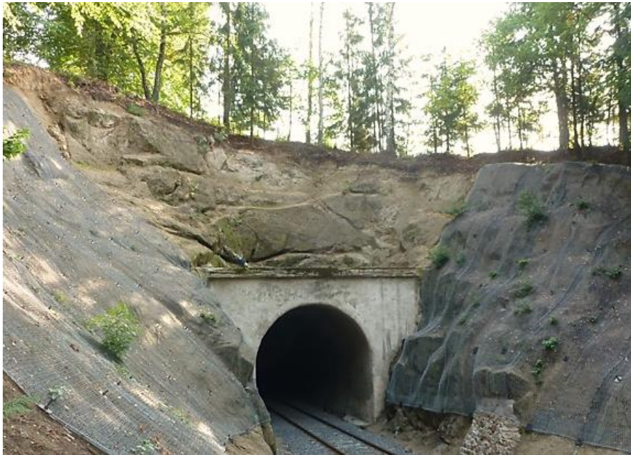
Obr.29 Železniční trať č.036, jablonecký portál prosečského tunelu v km 10,215 (archiv autora)
