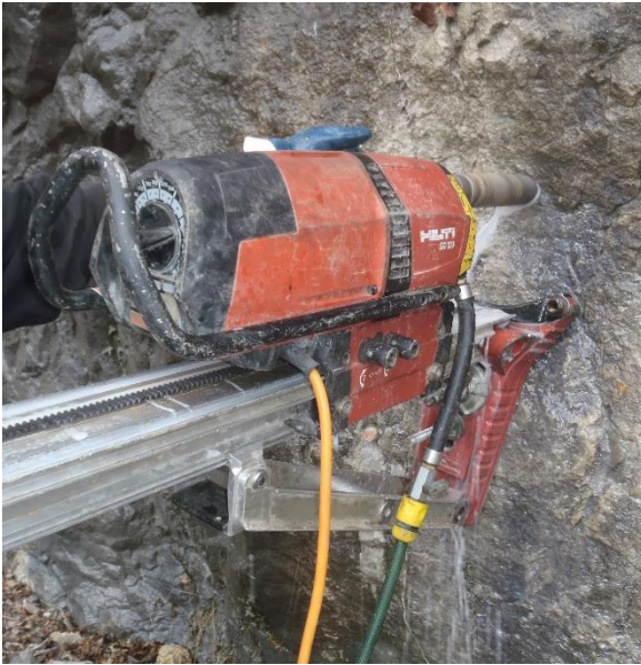
Obr.24 Hanušovice - jádrové vrtání pr. 50 mm (archiv autora)
