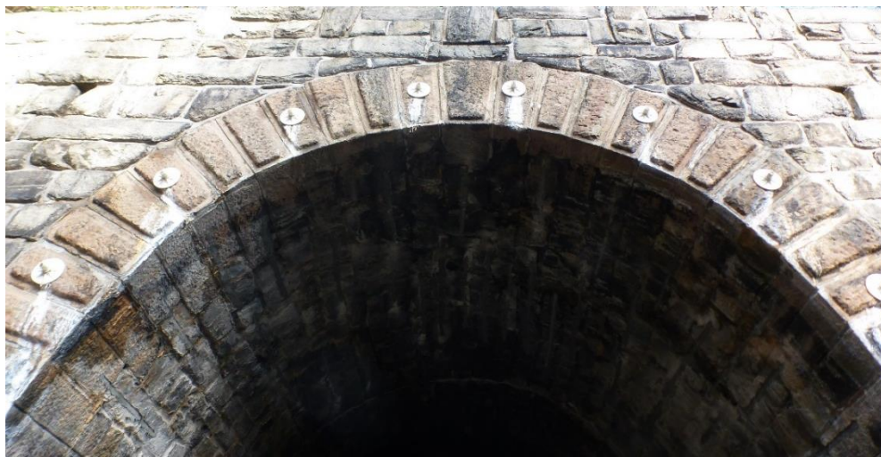
Obr.21 Doubravnický tunel, trať č. 251 Žďár n. S. v km 85,200 - kotvení obezdívky boračského portálu sklolaminátovými svorníky (archiv autora)
