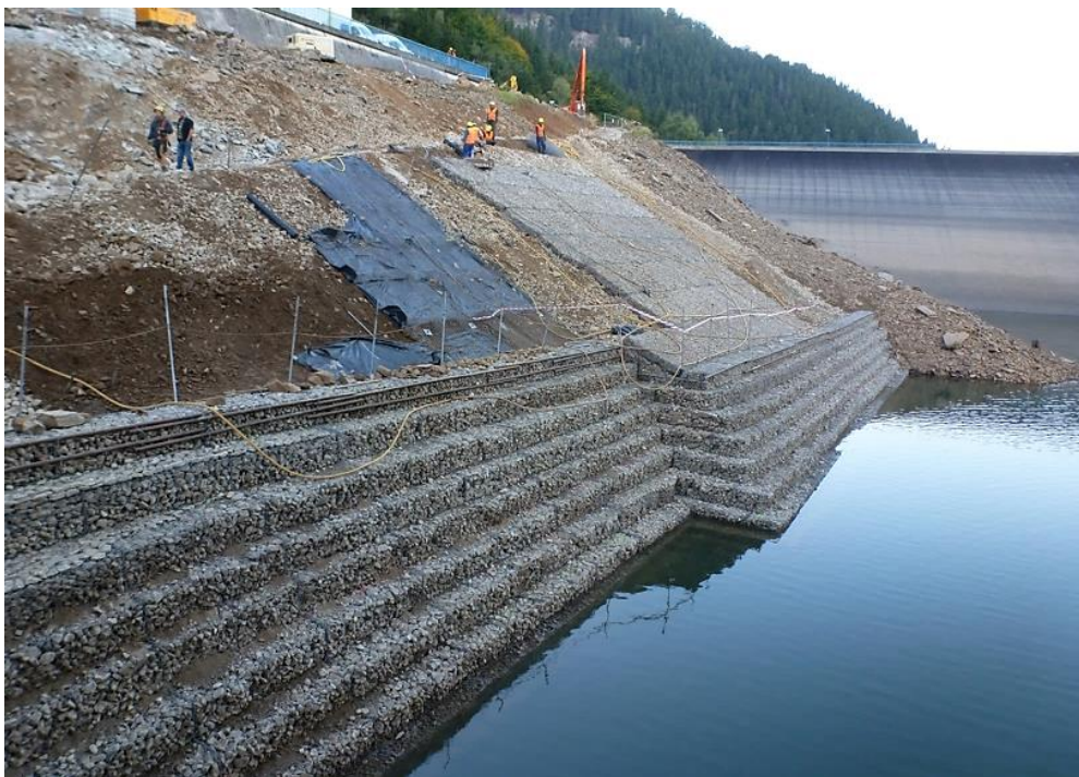
Obr.31 PVE DS, práce probíhaly kontinuálně i během zatápění, patrné opevnění břehového pásma (archiv autora)
