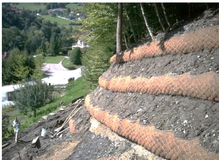
Obr.15 Chorvatsko - sanace poloskálního svahu (foto poskytl M. Šubic)
