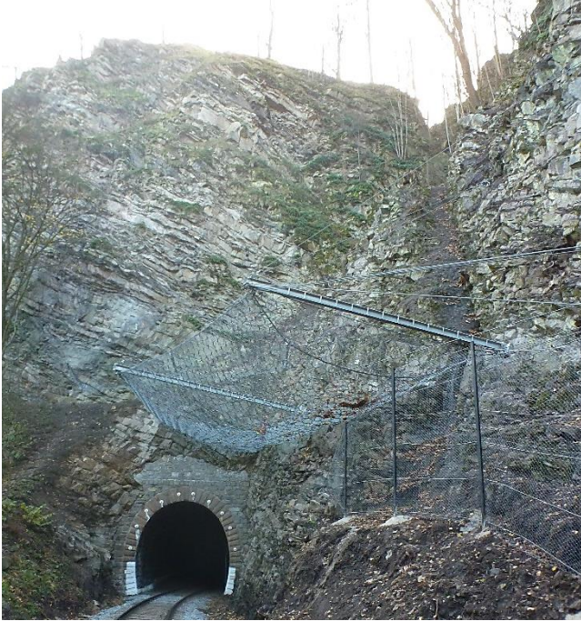
Obr.9 Doubravnický tunel na trati č. 251 Žďár n. S. – Tišnov v km 85,200; modifikovaná galerie doubravnického portálu tvořená dynamickou bariérou výšky 8,0 a 3,0 m (archiv autora)
