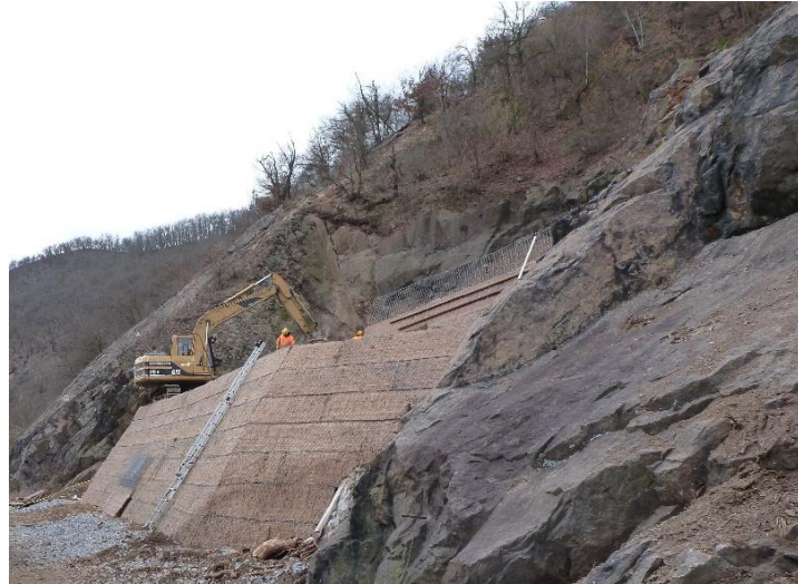
Obr.8 Silnice II/102 v úseku Strnady-Měchenice; vyztužený val – první realizace v ČR (archiv autora)
