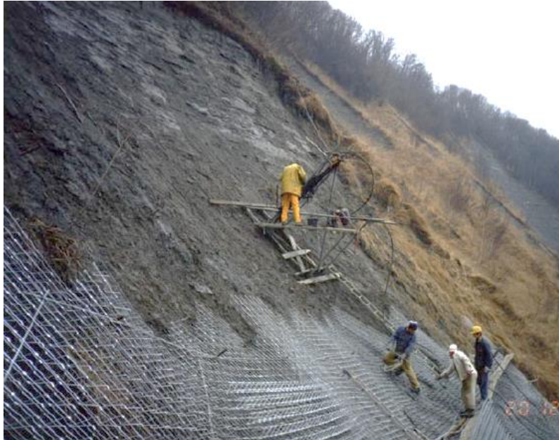
Obr.14 Silnice mezi Štýrskem a Sv. Valentýnem v Rakousku - sanace skalního svahu (foto poskytl R. Krismer)
