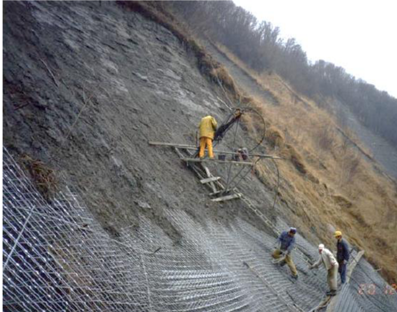
Obr.14 Silnice mezi Štýrskem a Sv. Valentýnem v Rakousku - sanace skalního svahu (foto poskytl R. Krismer)
