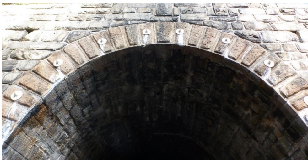
Obr.21 Doubravnický tunel, trat' č. 251 Žďár n. S. v km 85,200 - kotvení obezdívky boračského portálu sklolaminátovými svorníky (archiv autora)
