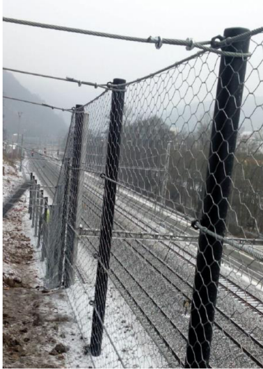
Obr.7 Trať č. 260 Brno – Č. Třebová km 171,330-171,650; těžký ochranný plot v. 2 m (archiv autora)
