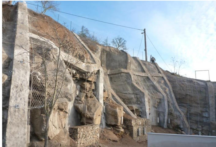
Obr.16 Tišnov, ul. Klášterská - sanace skalní stěny v zadním traktu obytného domu; ŽB žebra a aplikace SB se zavěšenými ocel. sítěmi v devonských vápencích (archiv autora)
