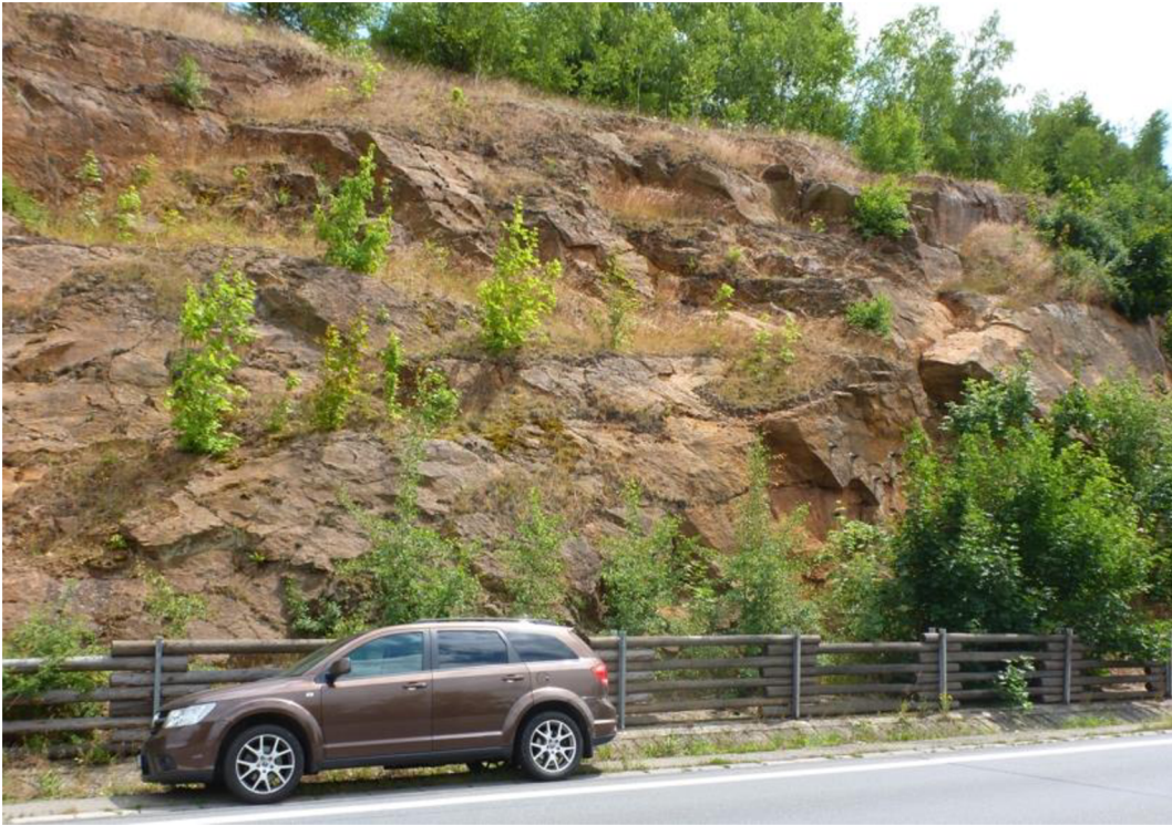
Obr.30 Silnice I/35 - stěna zářezu obchvatu Moravské Třebové (archiv autora)
