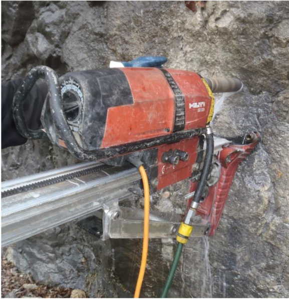
Obr.24 Hanušovice - jádrové vrtání pr. 50 mm (archiv autora)
