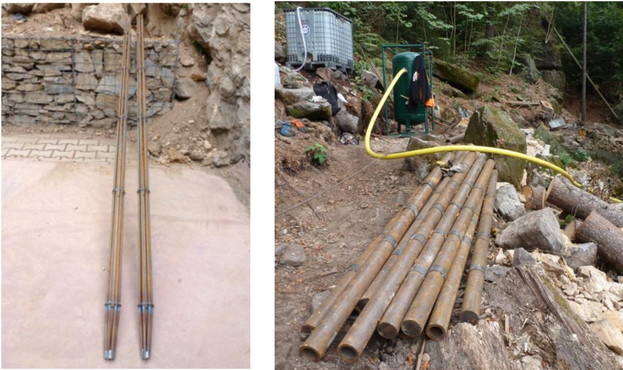
Obr.18 Dolní Žleb - výztuž mikropilot při založení patek dynamických bariér (vpravo); Tišnov - založení roznášecího prahu (vlevo) (archiv autora)
