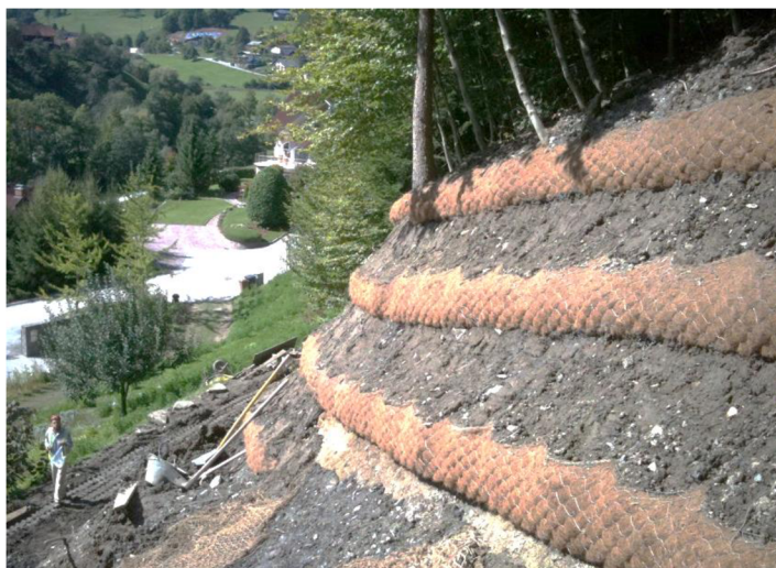
Obr.15 Chorvatsko - sanace poloskalního svahu (foto poskytl M. Šubic)
