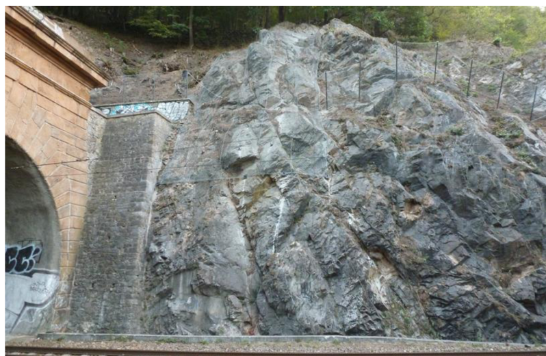
Obr.17 Tunel č. 8/1 - sanace skalní stěny u brněnského portálu, granodiorit typu Blansko (archiv autora)
