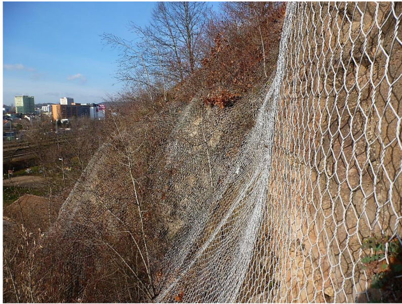
Obr.11 Brno-Královo Pole v ul. Myslínova; ocelová síť z r. 2006 ve formě závěsu s betonovým závažím, bývalý granodioritový lom (archiv autora)
