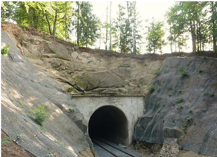
Obr.29 Železniční trať č.036, jablonecký portál prosečského tunelu v km 10,215 (archiv autora)
