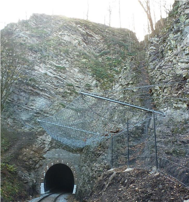
Obr.9 Doubavnický tunel na trati č. 251 Žďár n. S. – Tišnov v km 85,200; modifikovaná galerie doubavnického portálu tvořená dynamickou bariérou výšky 8,0 a 3,0 m (archiv autora)
