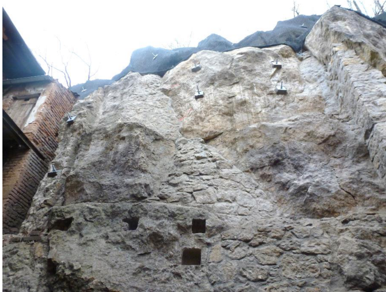
Obr.13 Krnsko - sanace skalní stěny v zadním traktu obytného domu, kombinace podezdívek, plomb a kotvení v kalliasových vápnatých pískovcích (archiv autora)
