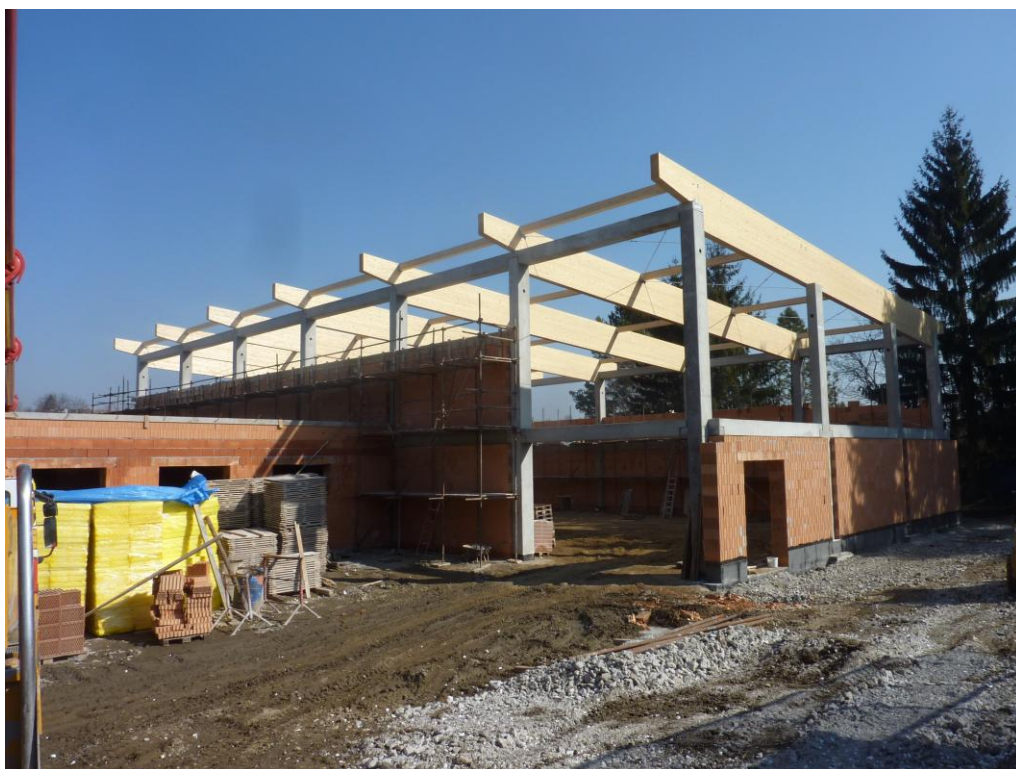
Obrázek č. 4.1 - Nosná konstrukce střešního pláště tělocvičny
