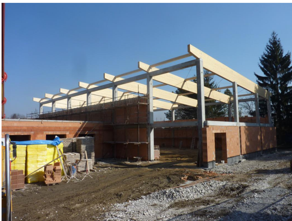
Obrázek č. 4.1 - Nosná konstrukce střešního pláště tělocvičny
