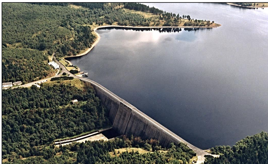
Obr. 6: Betonová pilířová hráz vodní nádrže Fláje (zdroj: Povodí Ohře, 2018).
