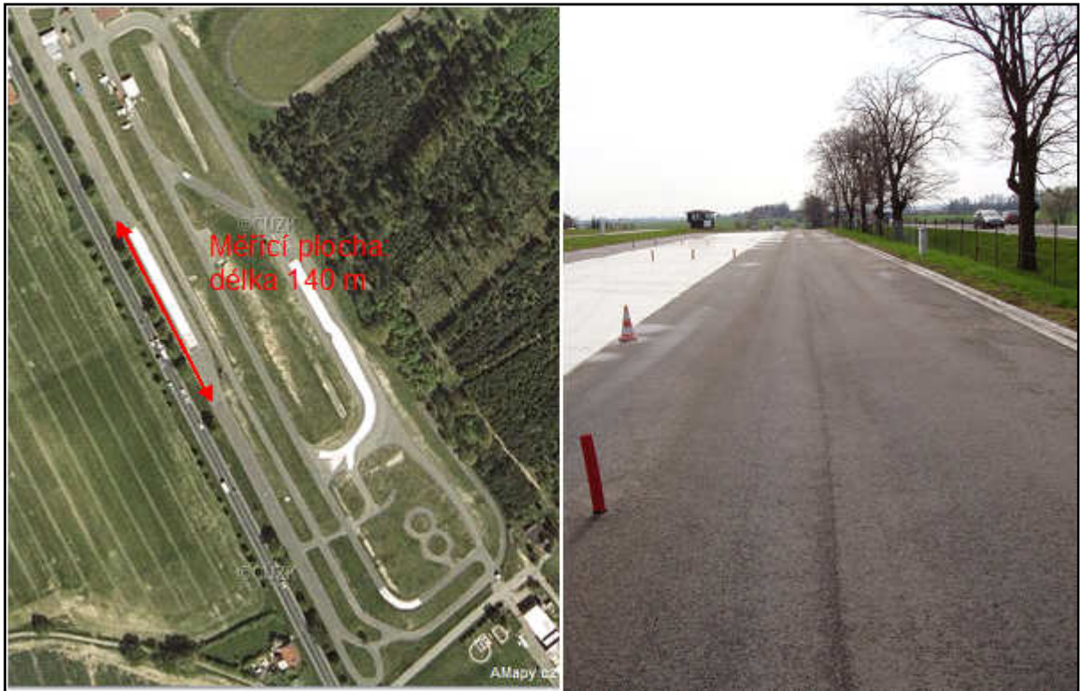
Obr. 8.6 – Pohled na zkušební dráhu. [18]
