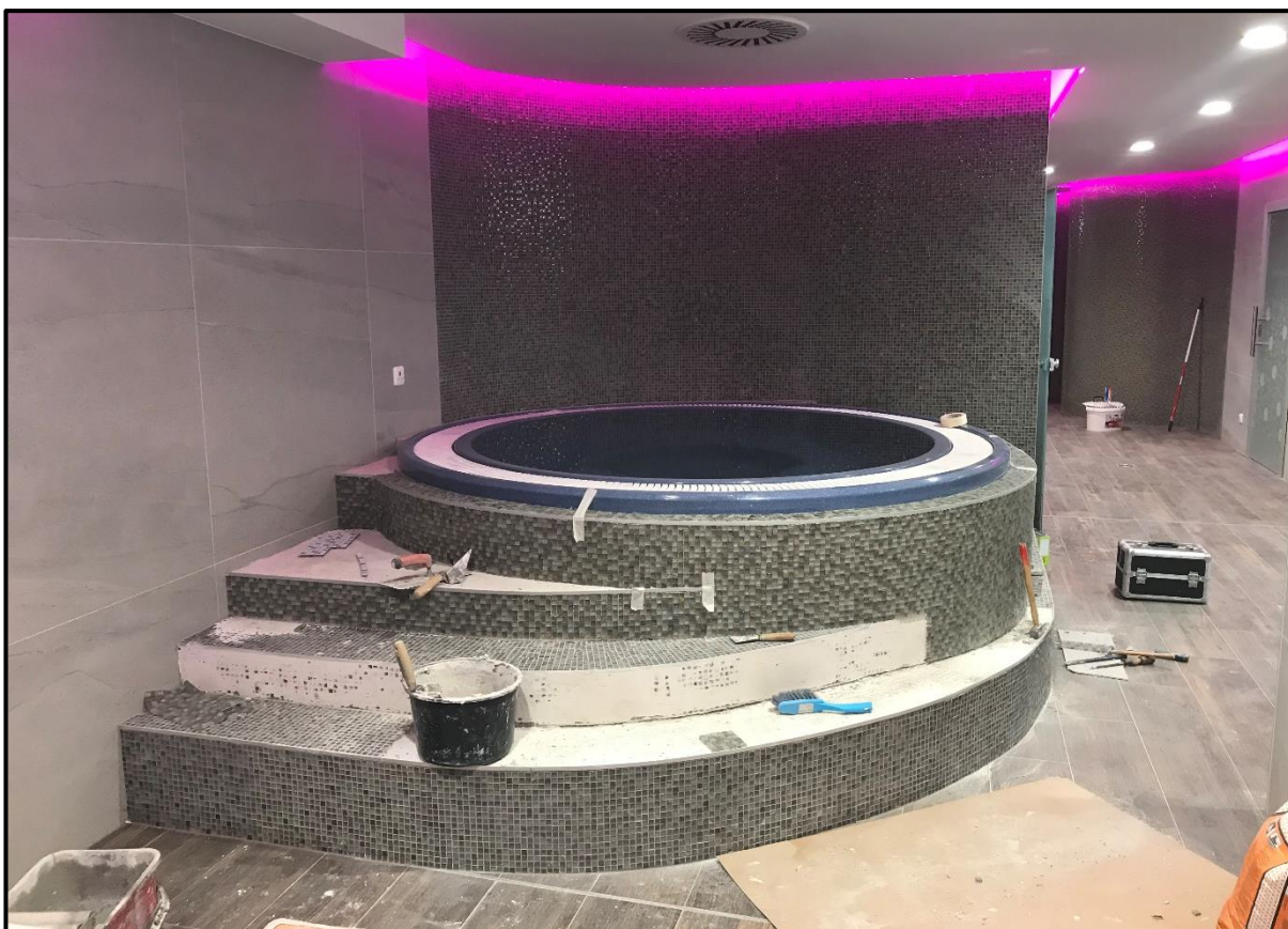
Obr. č. 14 – Dokončovací obkladačské práce v prostoru wellness centra [vlastní]
