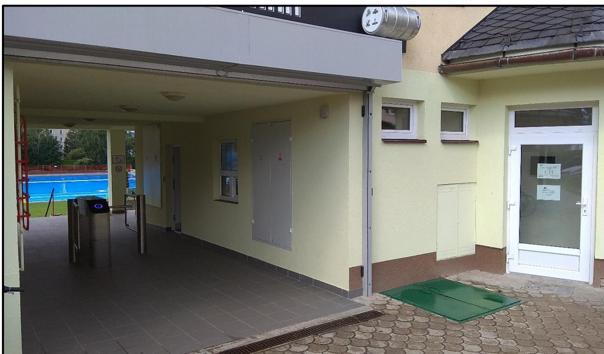
Obr. č. 16 – Turniketový vstup, rolovací mříž – nový stav středového průchodu objektu [vlastní]
