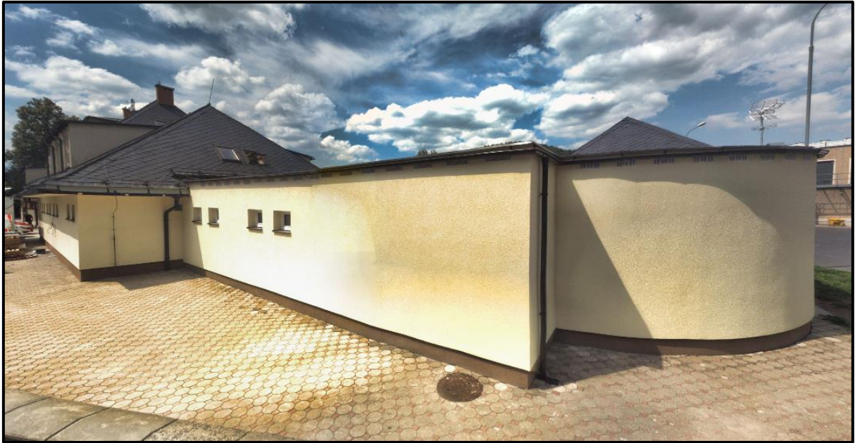
Obr. č. 15 – Pohled na nový stav východního křídla z ulice Dukelská [22]
