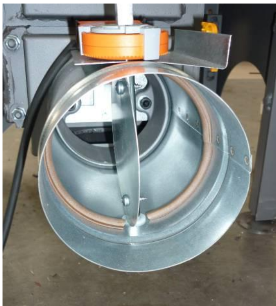
Obrázek 6.3: Detail regulační klapky se servopohonem
