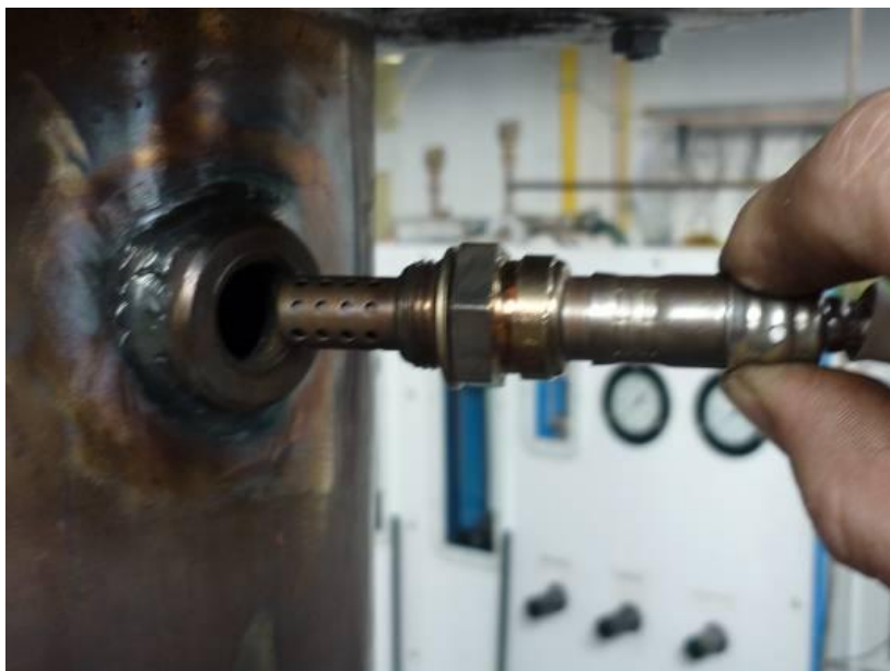
Obrázek 6.5: Instalace lambda sondy do kouřovodu
