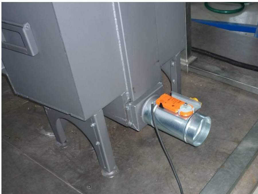
Obrázek 6.2: Instalovaná regulační klapka se servopohonem
