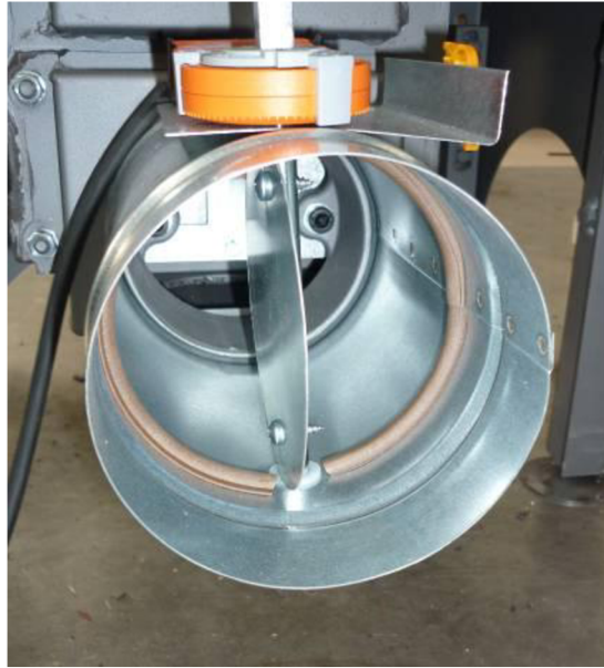
Obrázek 6.3: Detail regulační klapky se servopohonem
