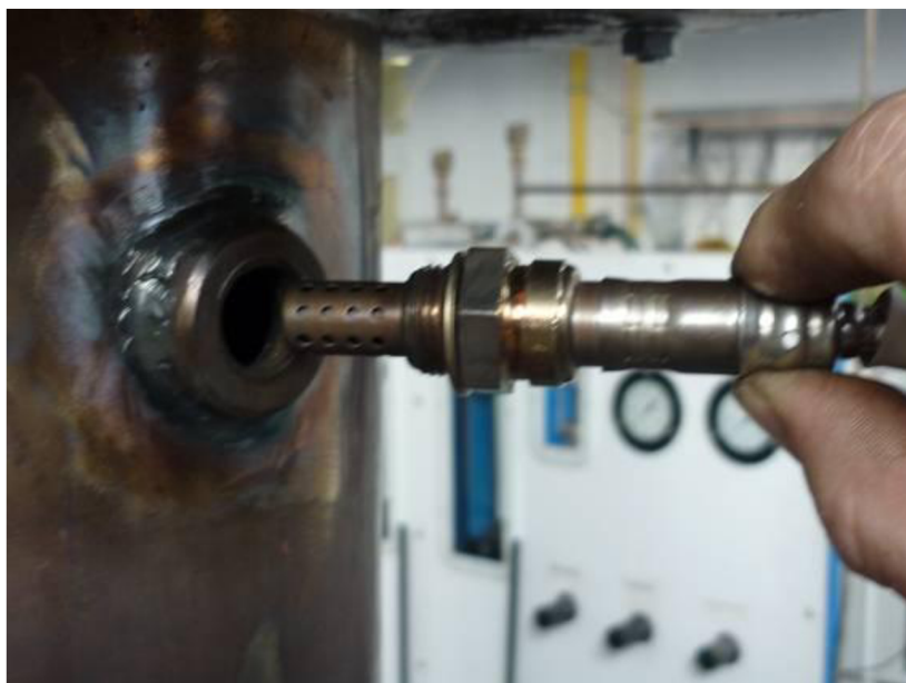
Obrázek 6.5: Instalace lambda sondy do kouřovodu
