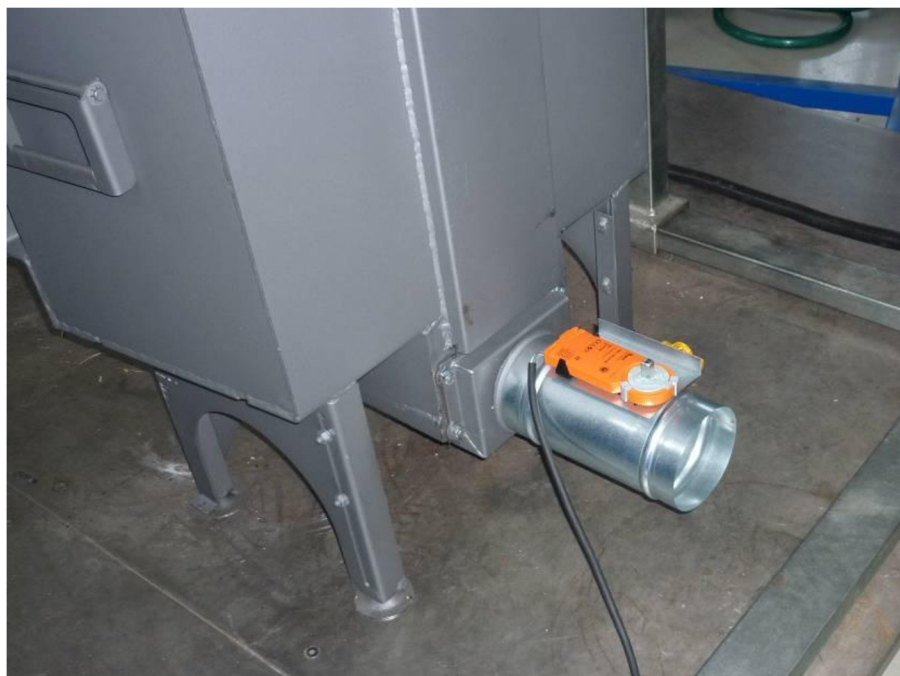
Obrázek 6.2: Instalovaná regulační klapka se servopohonem
