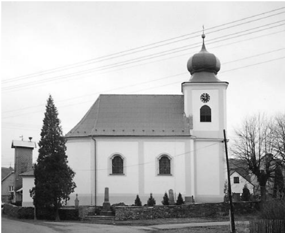
35. Albrechtice, kostel Navštívení Panny Marie, 1747—1752, transept.
