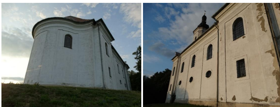
26. Bruntál, poutní kostel Panny Marie Pomocné na Uhlířském vrchu, kolem 1758, presbytář.
