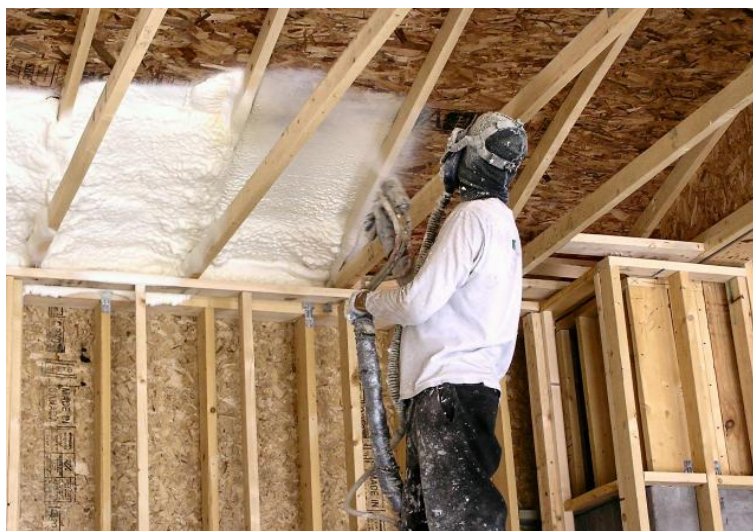
Obr. 23.: Aplikace PUR pěny [svet-drevostavby.cz].
