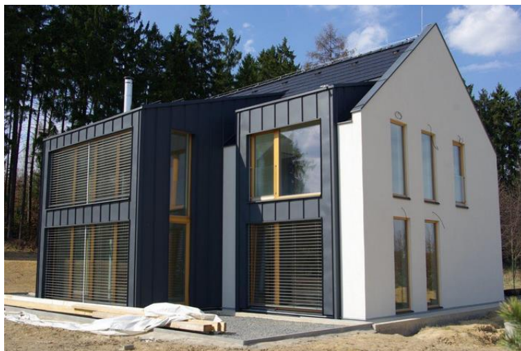
Obr. 9.: Nízkoenergetická dřevostavba v Nové Vsi pod Pleší [3AE].
