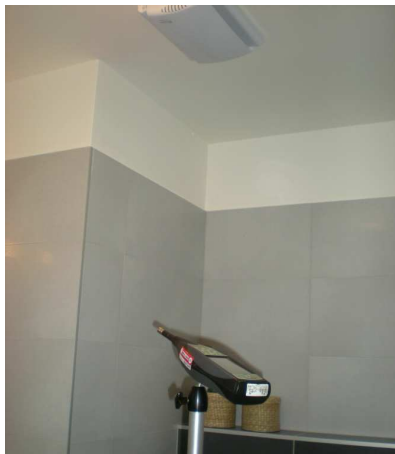
Obr. 3 Ukázka jednoho z měřených prostorů s ventilátorem
